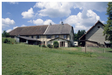
Façade postérieure. Phot. Yves Sancey IVR43_20009000431ZA
