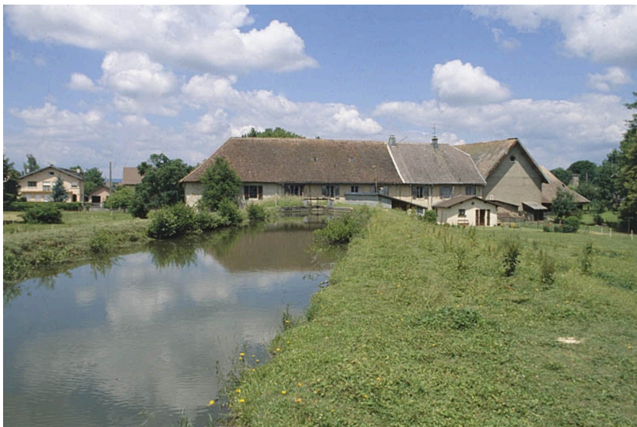
Canal d'amenée du moulin.
