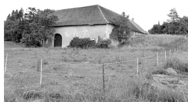
Le moulin depuis le sud. Phot. Yves Sancey IVR43_20009000436X
