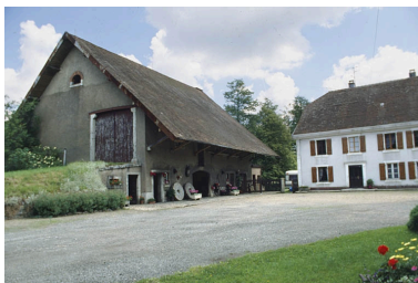
Parties agricoles : écurie et fenil. Phot. Yves Sancey IVR43_20009000427ZA
