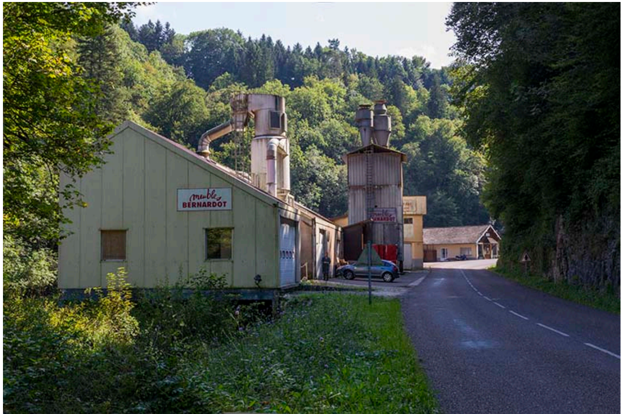
Vue d'ensemble du site, depuis le nord.
