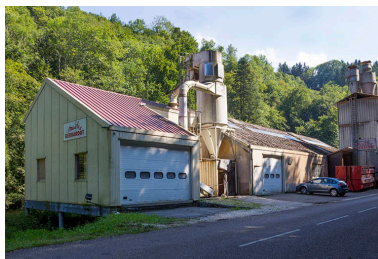
L'usine, depuis la route au nord : bâtiment postérieur à 1998 au premier plan, construit entre 1980 et 1988 au second plan Phot. Yves Sancey IVR43_20132501536NUC2A
