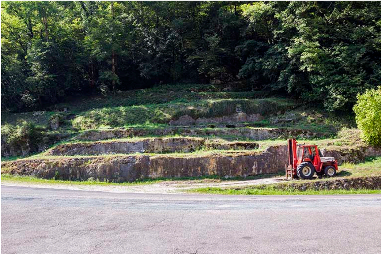
Emplacement du logement d'ouvriers détruit.
