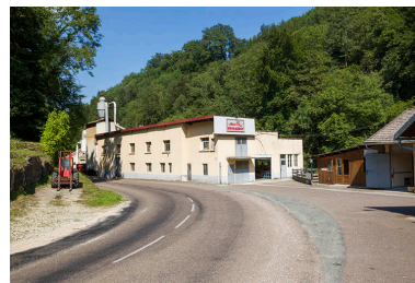
L'usine, depuis la route au sud : bâtiment refait en 1990. Phot. Yves Sancey IVR43_20132501530NUC2A
