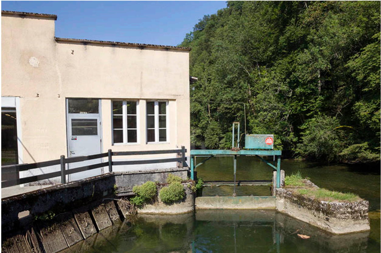
Le bâtiment d'eau et la vanne de décharge.
