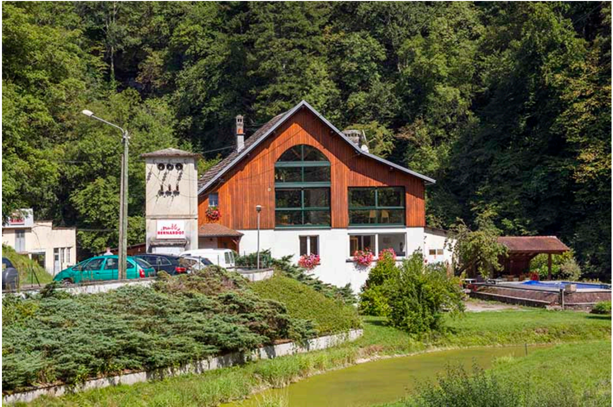
Le logement patronal et le transformateur, depuis l'ouest.
