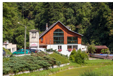
Le logement patronal et le transformateur, depuis l'ouest. Phot. Yves Sancey IVR43_20132501527NUC2A
