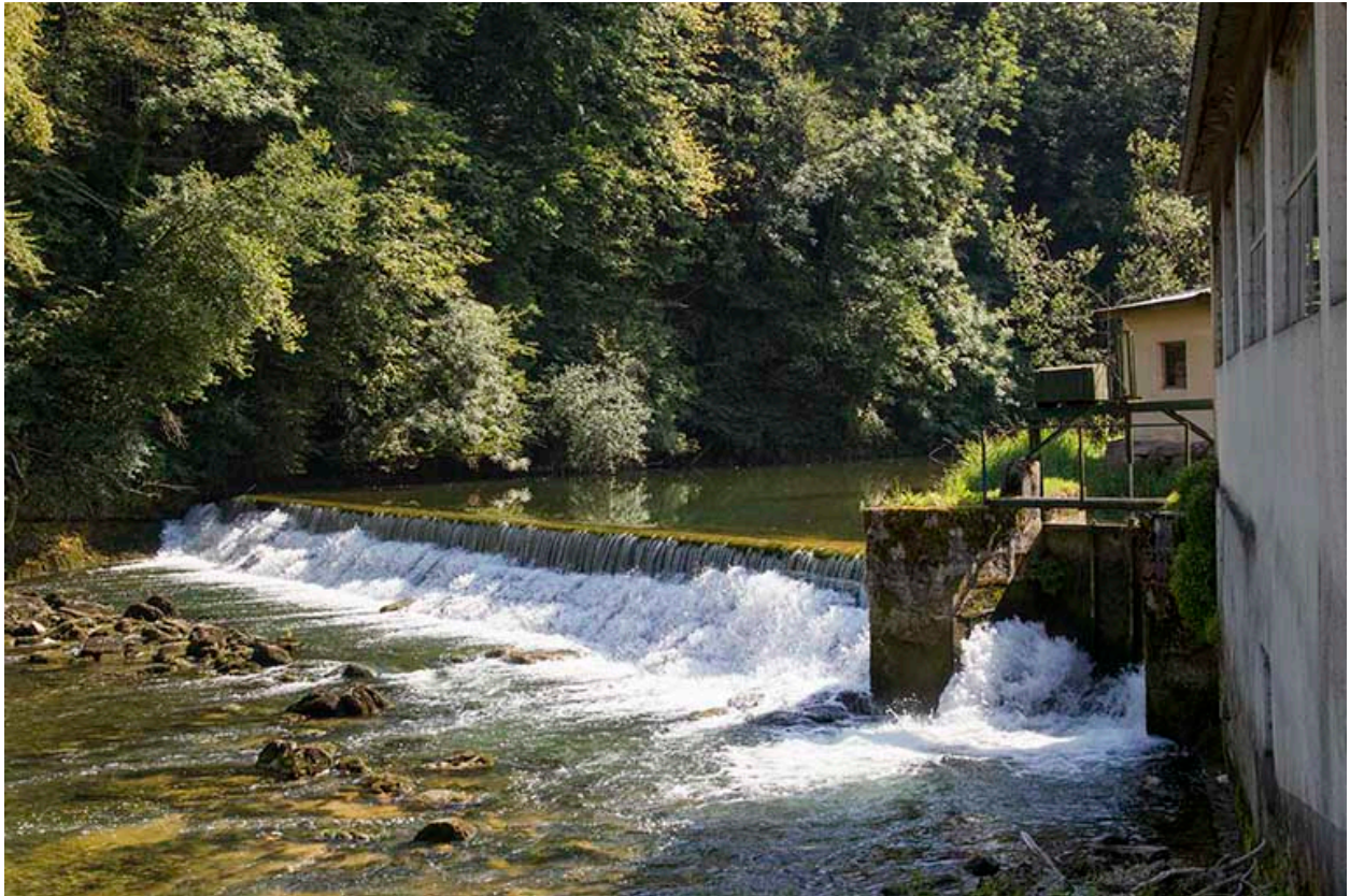
Le barrage et la vanne de décharge.
