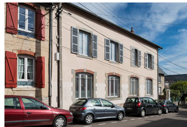
Façade sur rue. Phot. Jérôme Mongreville IVR43_20182500539NUC4A
