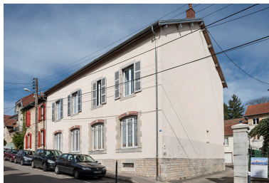
Vue de trois quarts droite. Phot. Jérôme Mongreville IVR43_20182500538NUC4A
