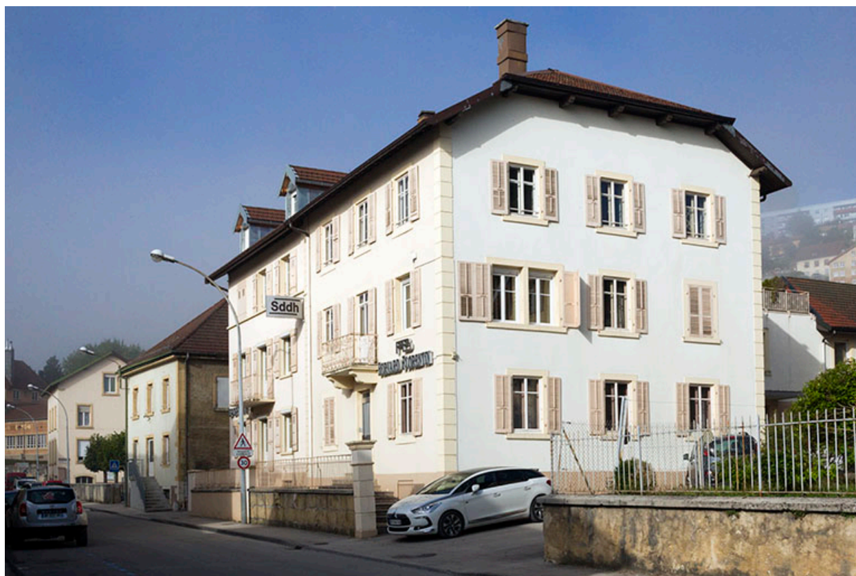
Façades antérieure et latérale droite.
