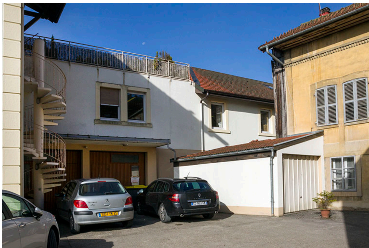
Magasin industriel au nord.
