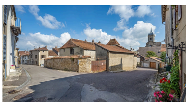
Angle sud-ouest de la maison, à l'angle des rues Patet-Traverse et Patet-Tournante. Phot. Jérôme Mongreville IVR43_20217000558NUC4A
