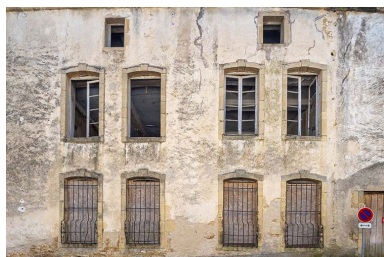
Le corps de logis sur la rue du Général-Etienne. Phot. Jérôme Mongreville IVR43_20217000557NUC4A
