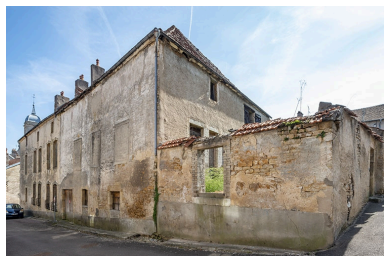
La façade sur la rue du Général-Etienne, de biais. Phot. Jérôme Mongreville IVR43_20217000556NUC4A
