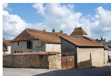
Vue rapprochée de l'angle sud-ouest de la maison, à l'angle des rues Patet-Traverse et Patet-Tournante. Phot. Jérôme Mongreville IVR43_20217000552NUC4A
