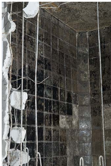
Détail d'une cuve en cours de démolition. Phot. Jérôme Mongreville IVR43_20097000329NUC2A
