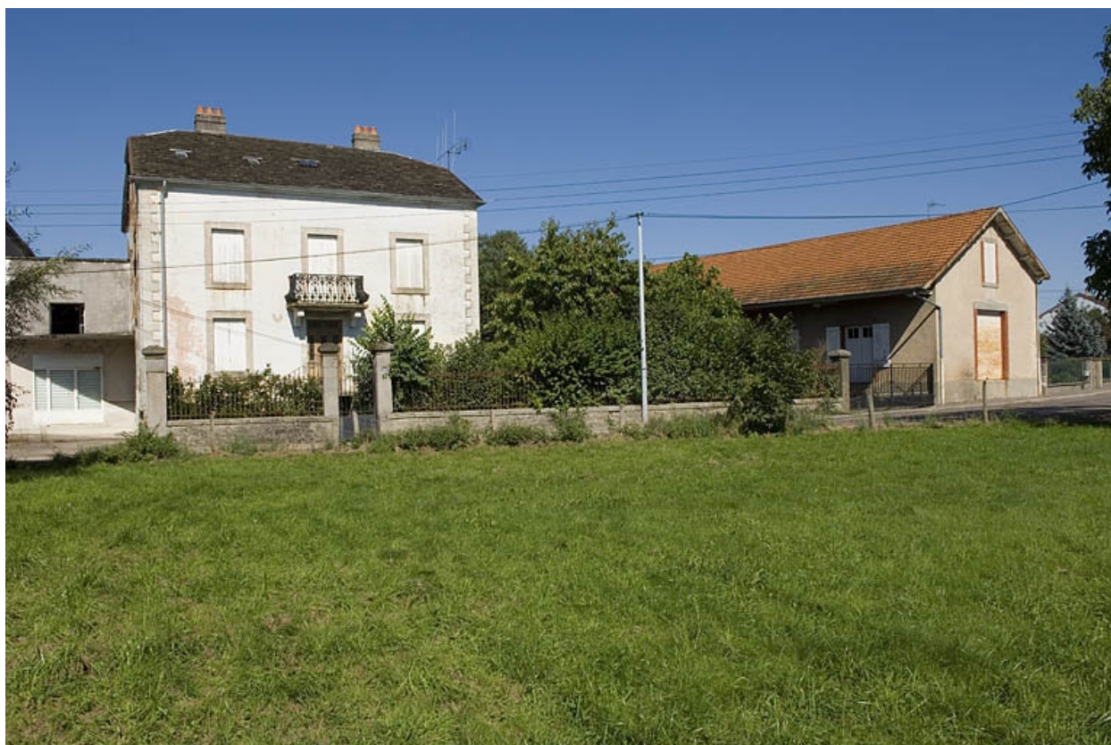
Vue depuis le sud.
