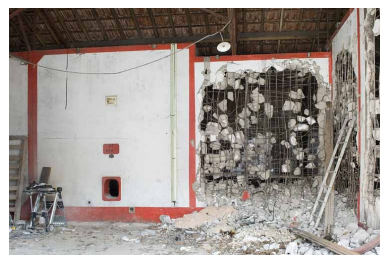
Cuverie. Cuves de fermentation en cours de démolition. Phot. Jérôme Mongreville IVR43_20097000328NUC2A
