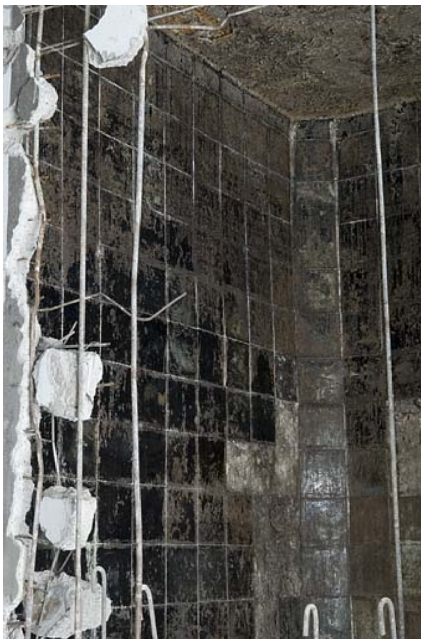
Détail d'une cuve en cours de démolition.
