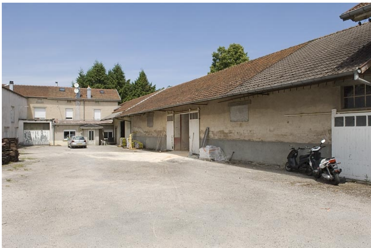
Logement et cuverie.
