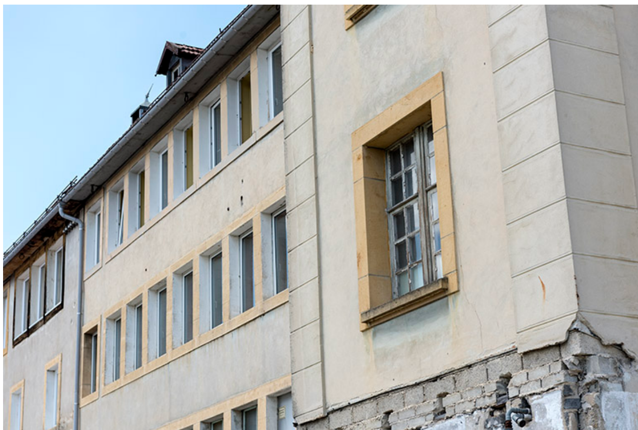
Usine : fenêtres multiples sur la façade postérieure.
