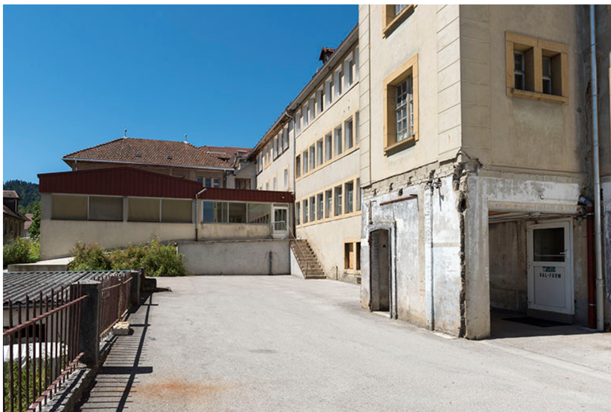
Usine : atelier de mécanique (façade latérale gauche).
