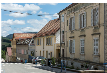
Vue d'ensemble, depuis la rue Parrenin. Phot. Sonia Dourlot IVR43_20162501778NUC4A
