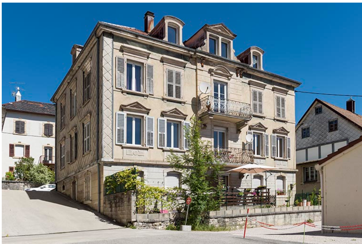
Maison : façades postérieure et latérale droite.
