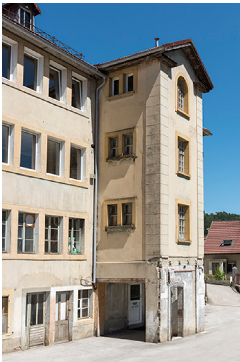
Usine : extrémité nord de la façade postérieure.
