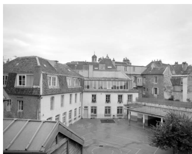
Vue d'ensemble de la deuxième cour.
