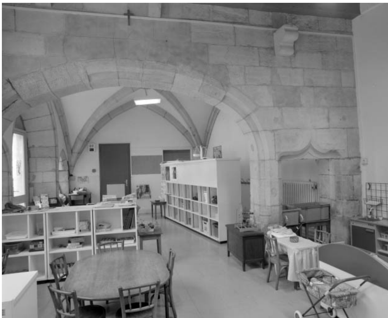
Intérieur : rez-de-chaussée de la partie gauche du bâtiment à droite de la deuxième cour : vue d'ensemble de face.
