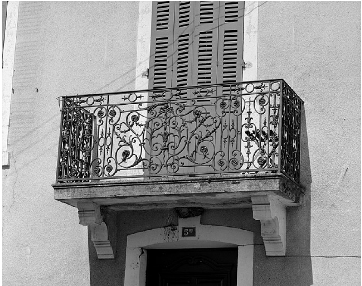
Détail : balcon en ferronnerie d'une baie du premier étage.
