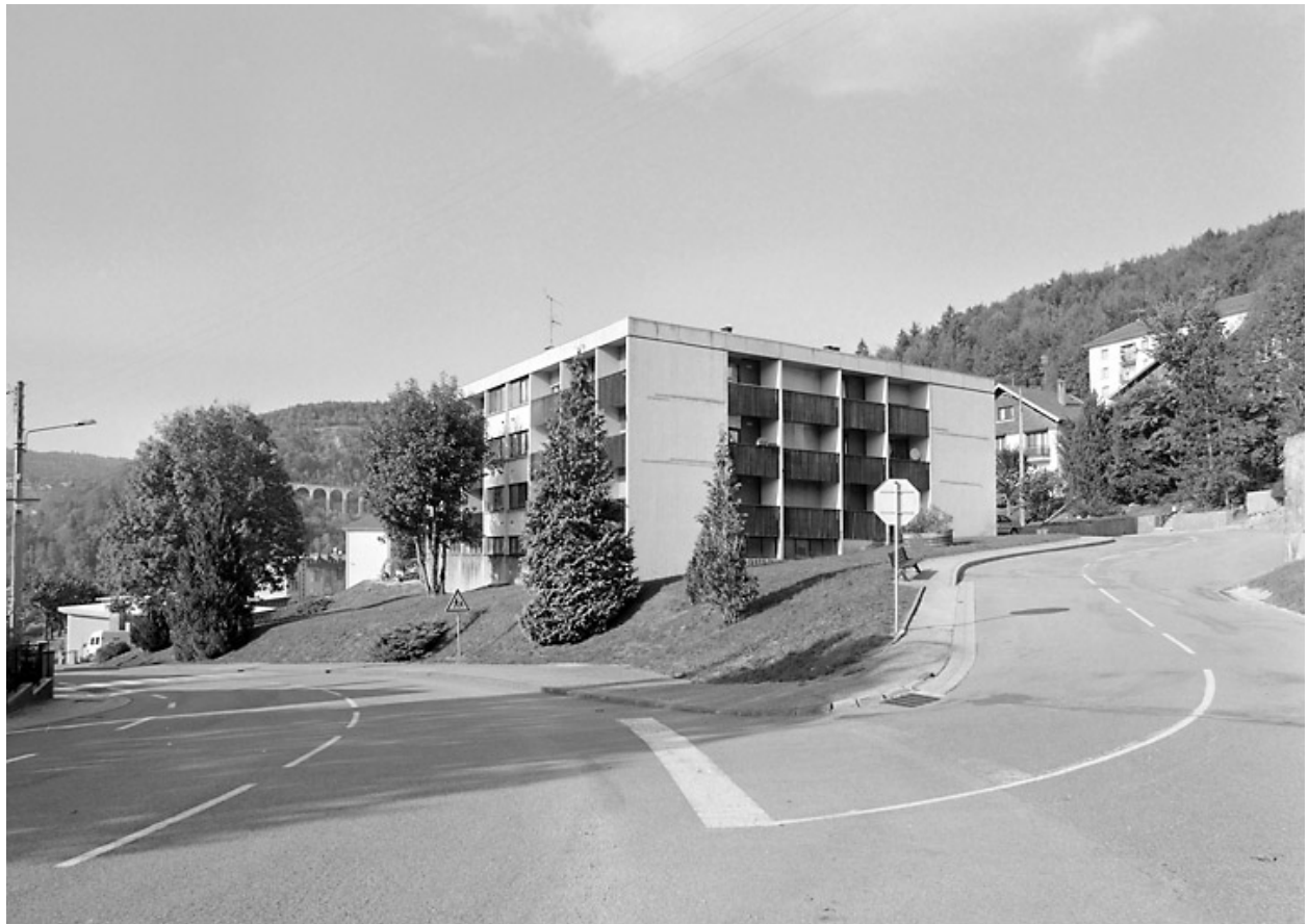
Ancien centre commercial, 25 avenue de la Libération.
