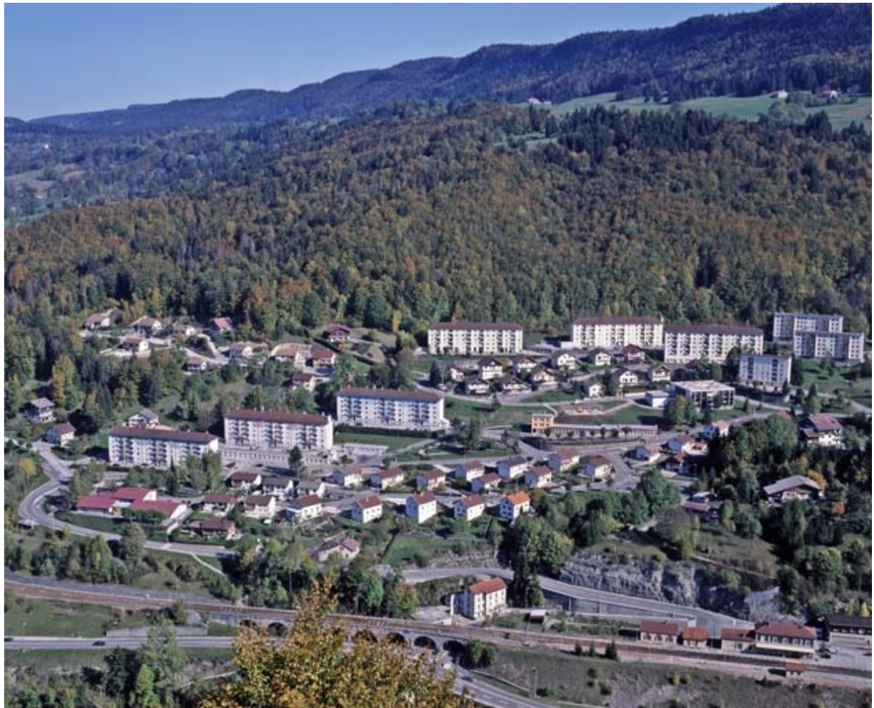
Vue d'ensemble plongeante depuis l'ouest.
