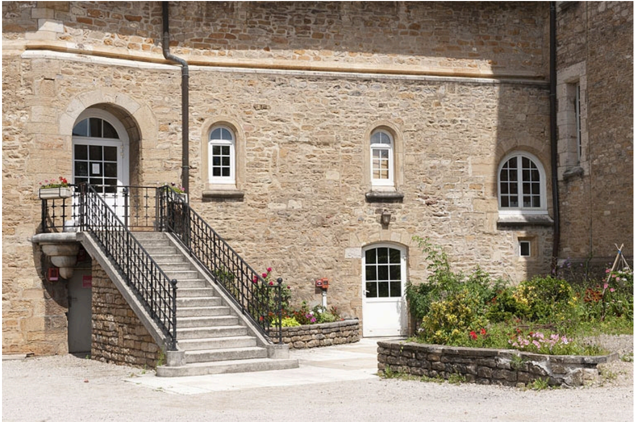
Bâtiment (C), escalier côté cour.
