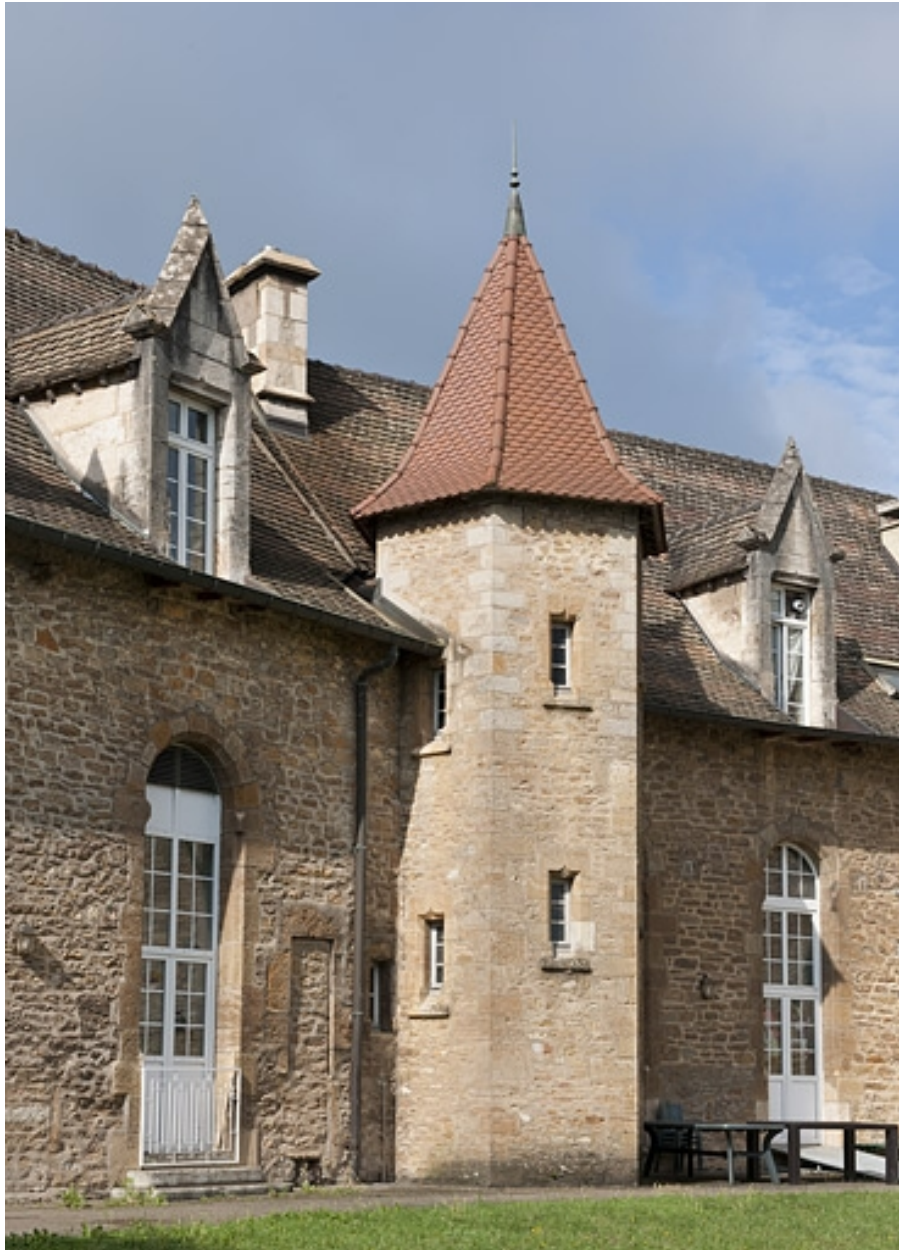
Bâtiment (C), côté jardin, détail de la tour d'escalier.
