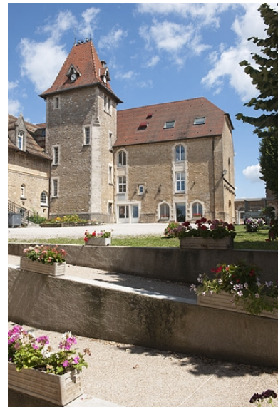
Bâtiment (C), tour d'escalier et chapelle (D), vue depuis l'entrée. Phot. Jérôme Mongreville IVR43_20102501398NUC4A
