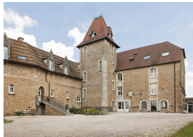
Bâtiment (C) et chapelle (D), vue depuis la cour. Phot. Jérôme Mongreville IVR43_20102501392NUC4A
