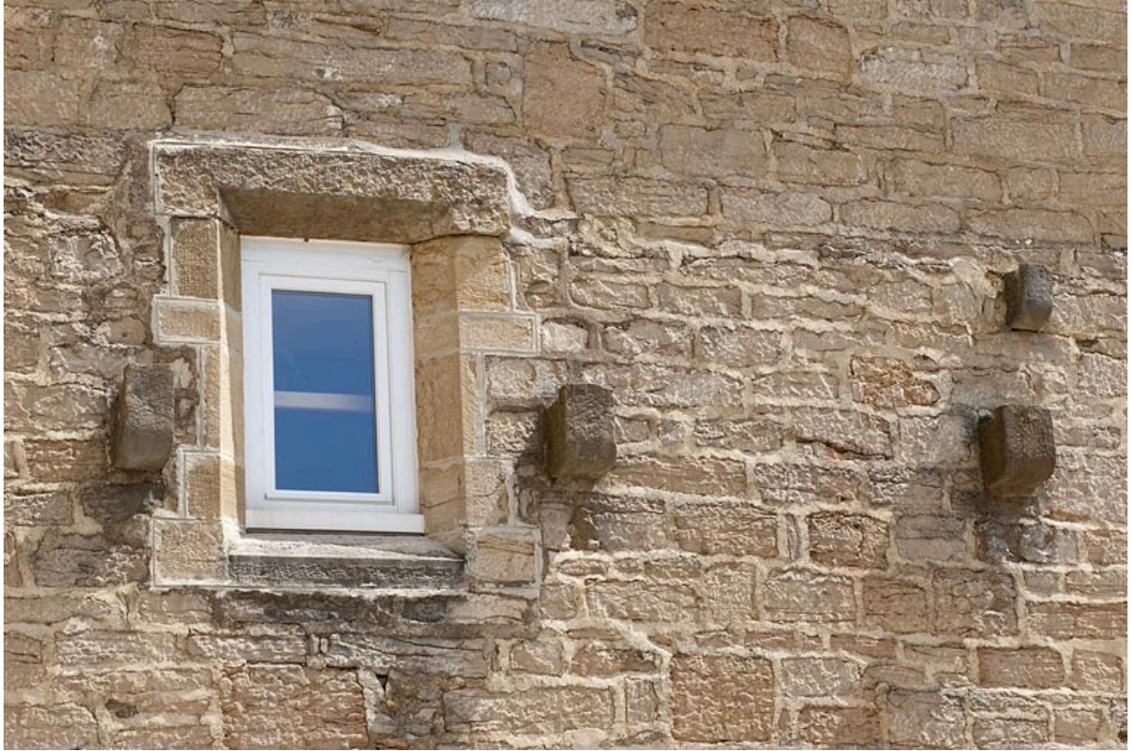
Chapelle (D), vue d'une baie.
