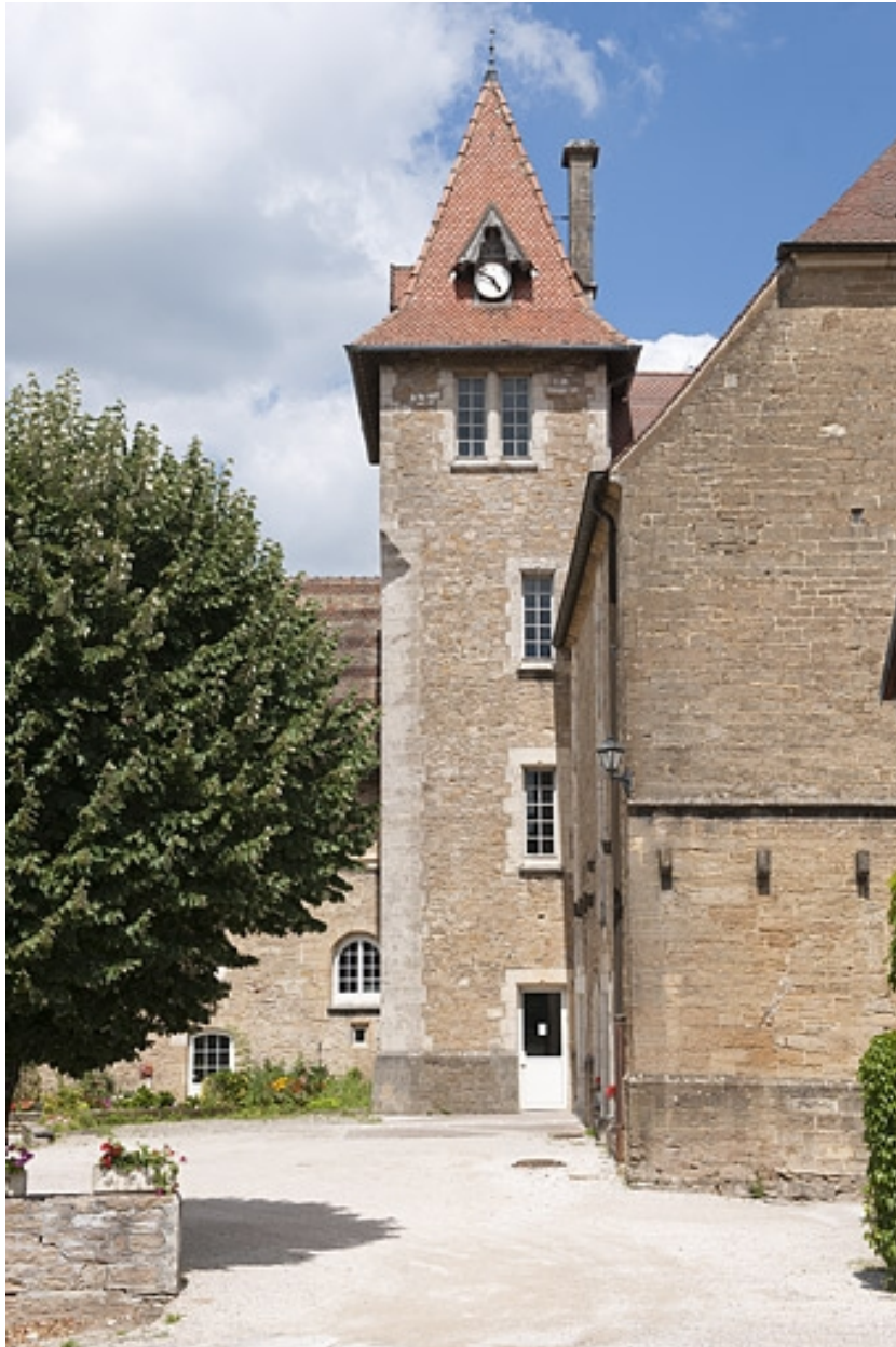
Bâtiment (C), vue de la tour d'escalier.
