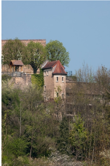
Bâtiment (H), tour d'escalier. Phot. Jérôme Mongreville IVR43_20102500719NUC4A
