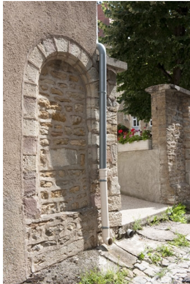
Bâtiment (B), ancienne porte. Phot. Jérôme Mongreville IVR43_20102501362NUC4A
