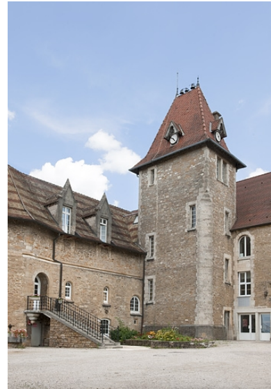
Bâtiment (C), tour d'escalier et escalier côté cour. Phot. Jérôme Mongreville IVR43_20102501386NUC4A
