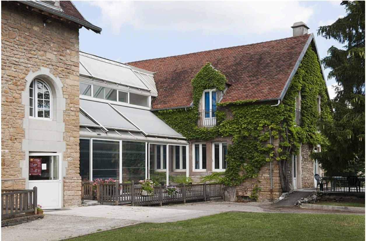
Bâtiment (G) relié au bâtiment (A) par une galerie vitrée.
