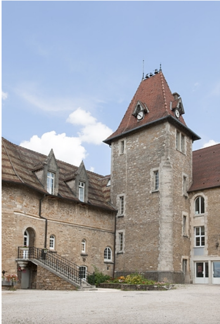
Bâtiment (C), tour d'escalier et escalier côté cour.
