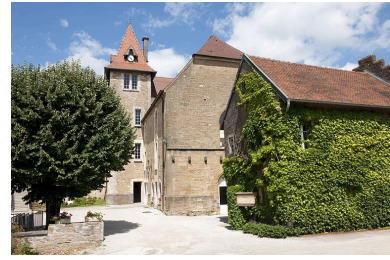
Bâtiment (C), tour d'escalier, chapelle (D), demeure de Philibert de Molans (F). Phot. Jérôme Mongreville IVR43_20102501397NUC4A
