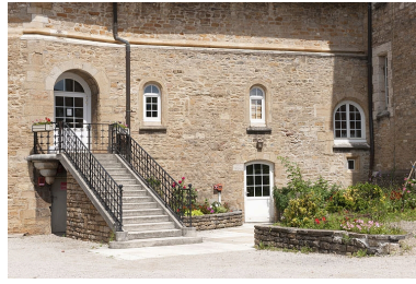
Bâtiment (C), escalier côté cour. Phot. Jérôme Mongreville IVR43_20102501384NUC4A
