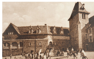
Rougemont (Doubs) - La Maison d'Enfants - Une cour. S.d. [1 ère moitié 20 e siècle]. Phot. Jérôme Mongreville, Autr. auteur inconnu IVR43_20102500600NUC4A
