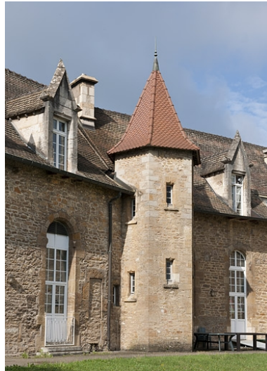
Bâtiment (C), côté jardin, détail de la tour d'escalier. Phot. Jérôme Mongreville IVR43_20102501378NUC4A
