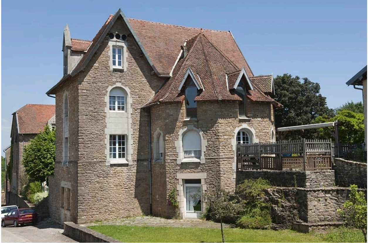
Bâtiment (G), vue rapprochée.
