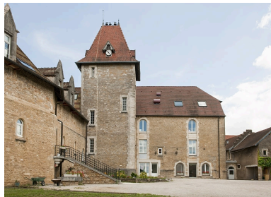
Bâtiment (C) et chapelle (D), vue depuis la cour. Phot. Jérôme Mongreville IVR43_20102501393NUC4A
