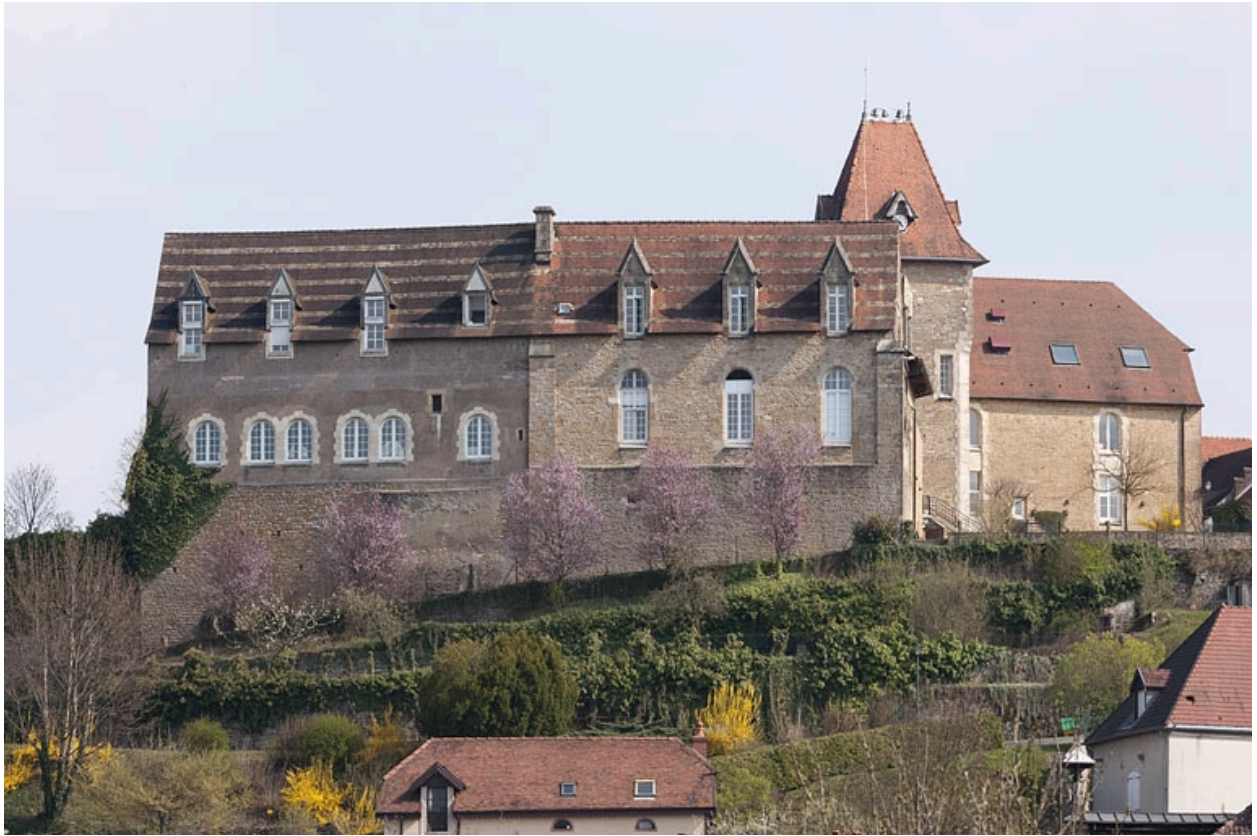
Bâtiment (C) et chapelle (D), vue depuis le village.
