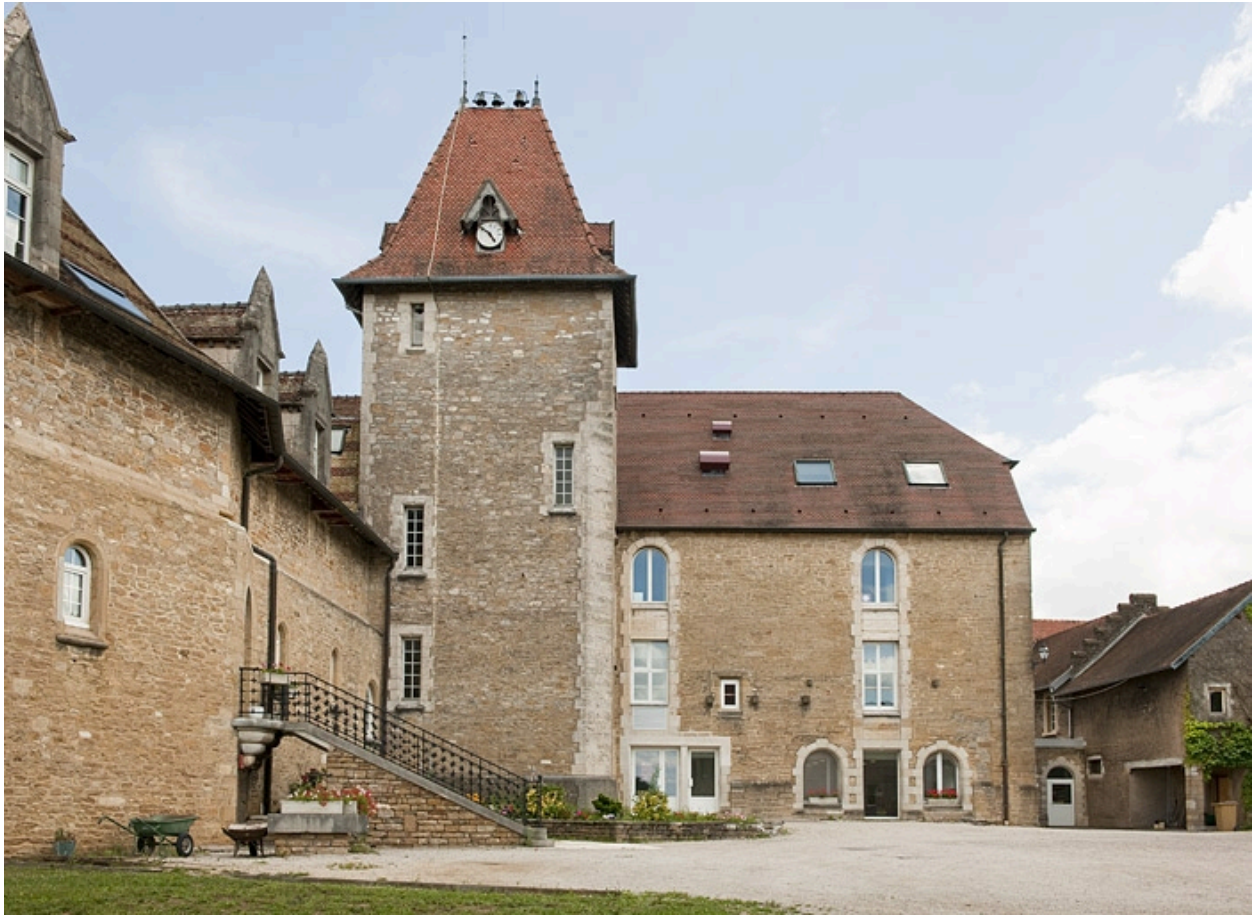
Bâtiment (C) et chapelle (D), vue depuis la cour.
