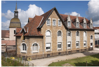
Bâtiment (G), façade postérieure, vue de trois quart gauche. Phot. Jérôme Mongreville IVR43_20102501369NUC4A
