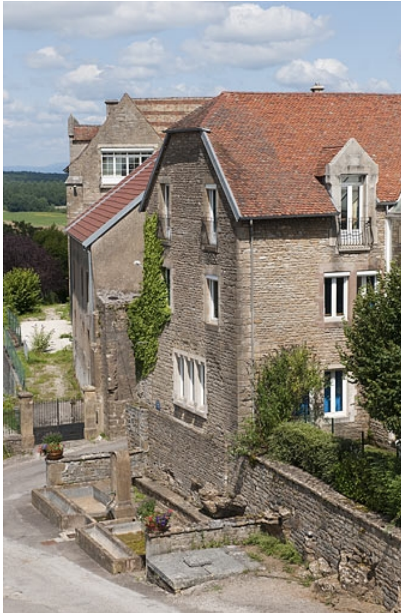
Bâtiment (A), vue rapprochée du côté rue.
