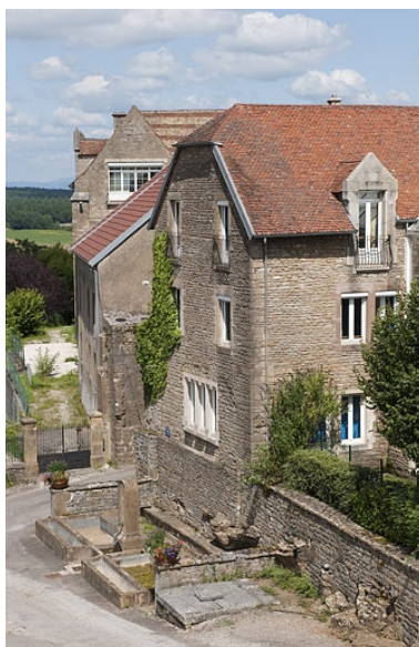
Bâtiment (A), vue rapprochée du côté rue. Phot. Jérôme Mongreville IVR43_20102501374NUC4A
