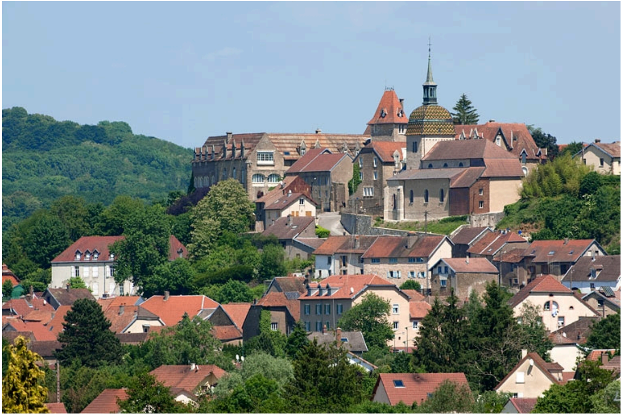
Vue générale depuis le sud-ouest.
