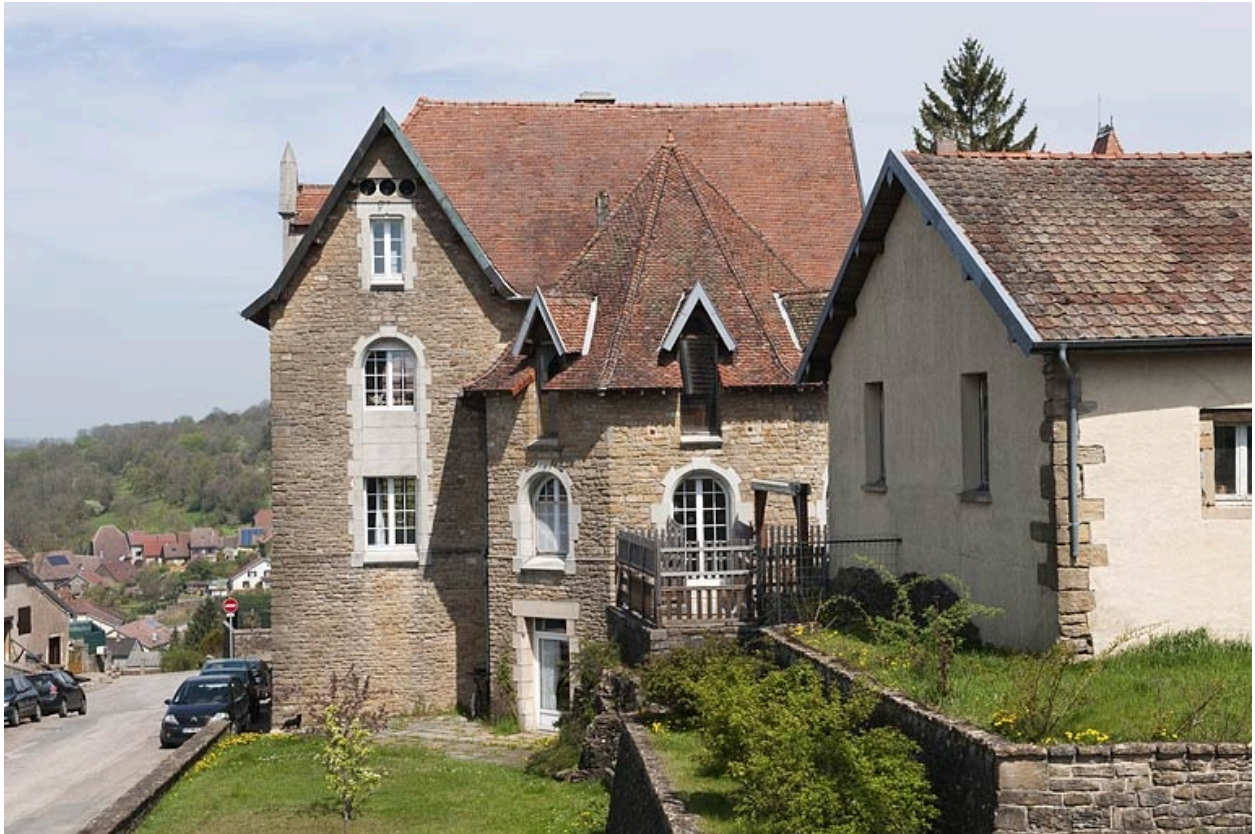
Bâtiment (G), côté rue.
