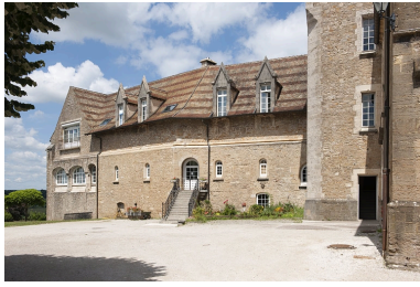
Bâtiment (C), vue depuis la cour. Phot. Jérôme Mongreville IVR43_20102501385NUC4A
