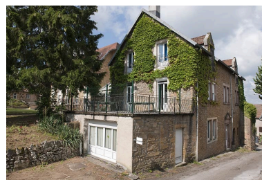
Bâtiment (A), vue de trois quart gauche. Phot. Jérôme Mongreville IVR43_20102501368NUC4A
