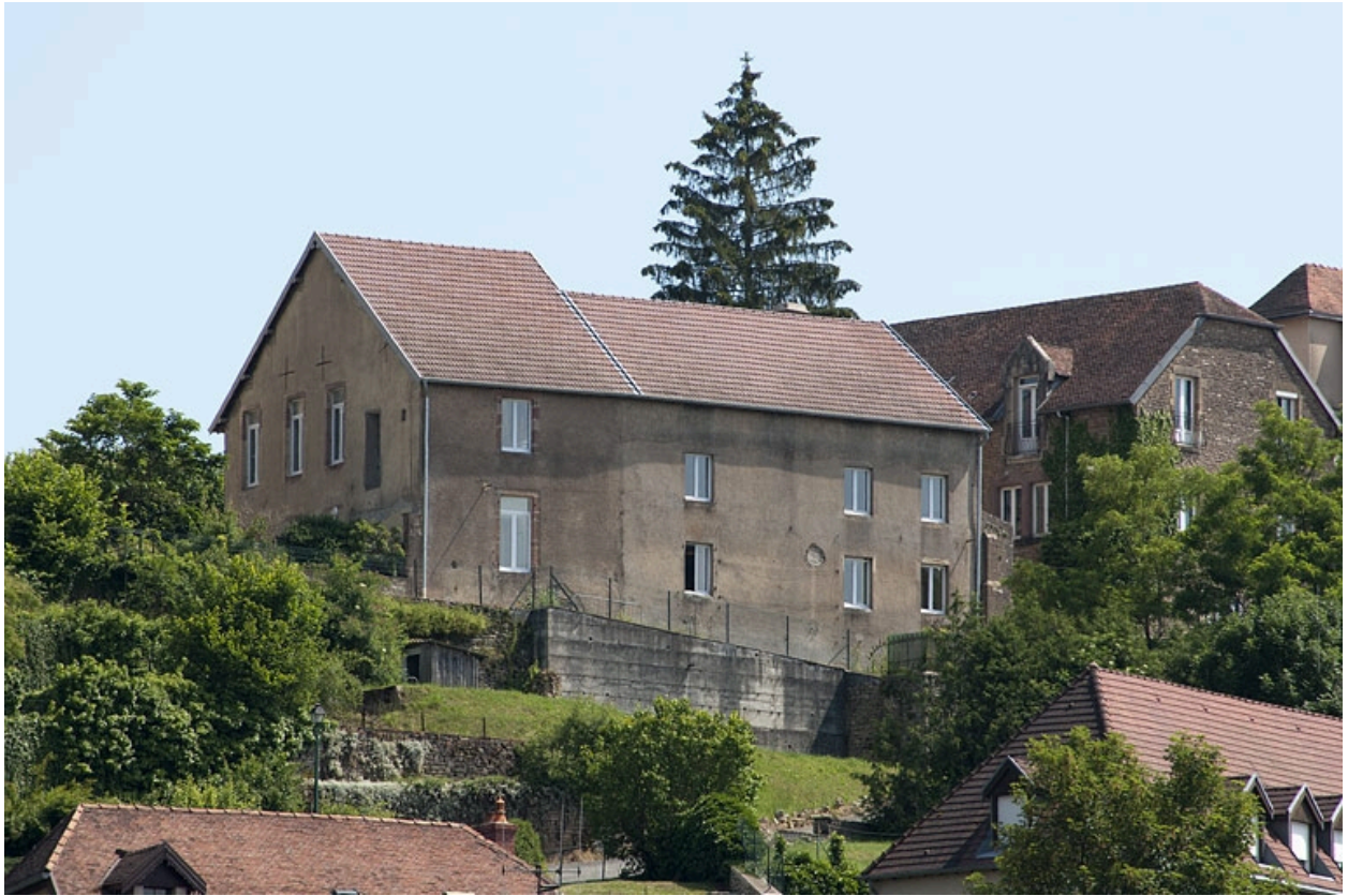
Bâtiment (B), vue générale côté village.
