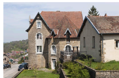
Bâtiment (G), côté rue. Phot. Jérôme Mongreville IVR43_20102501365NUC4A
