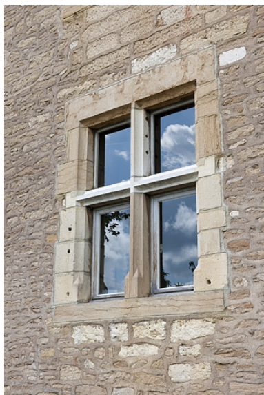
Demeure de Philibert de Molans (F), façade postérieure, détail d'une baie. Phot. Jérôme Mongreville IVR43_20102501391NUC4A
