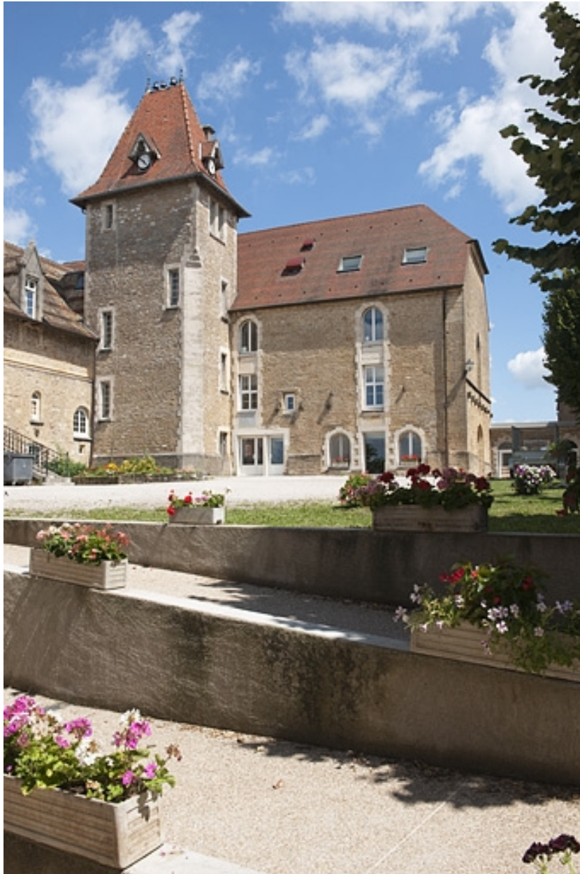
Bâtiment (C), tour d'escalier et chapelle (D), vue depuis l'entrée.
