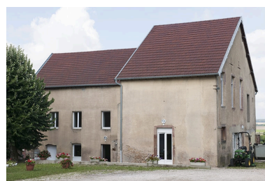
Bâtiment (B), vue d'ensemble depuis la cour. Phot. Jérôme Mongreville IVR43_20102501361NUC4A
