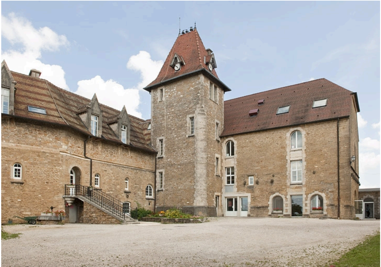
Bâtiment (C) et chapelle (D), vue depuis la cour.
