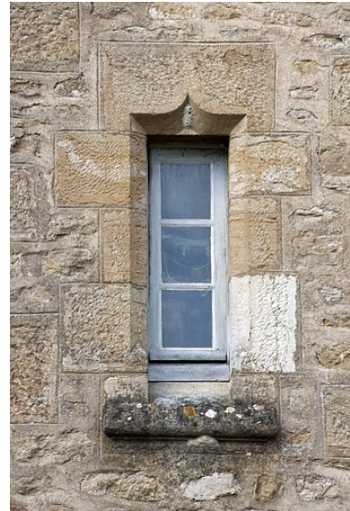
Bâtiment (C), façade côté jardin : détail d'une baie de la tour d'escalier. Phot. Jérôme Mongreville IVR43_20102501383NUC4A
