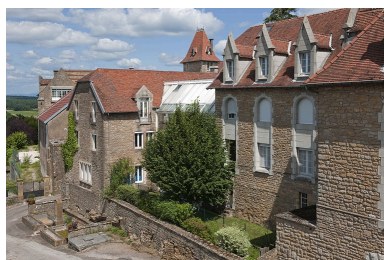
Bâtiment (A) et bâtiment (C), vue du côté rue. Phot. Jérôme Mongreville IVR43_20102501373NUC4A
