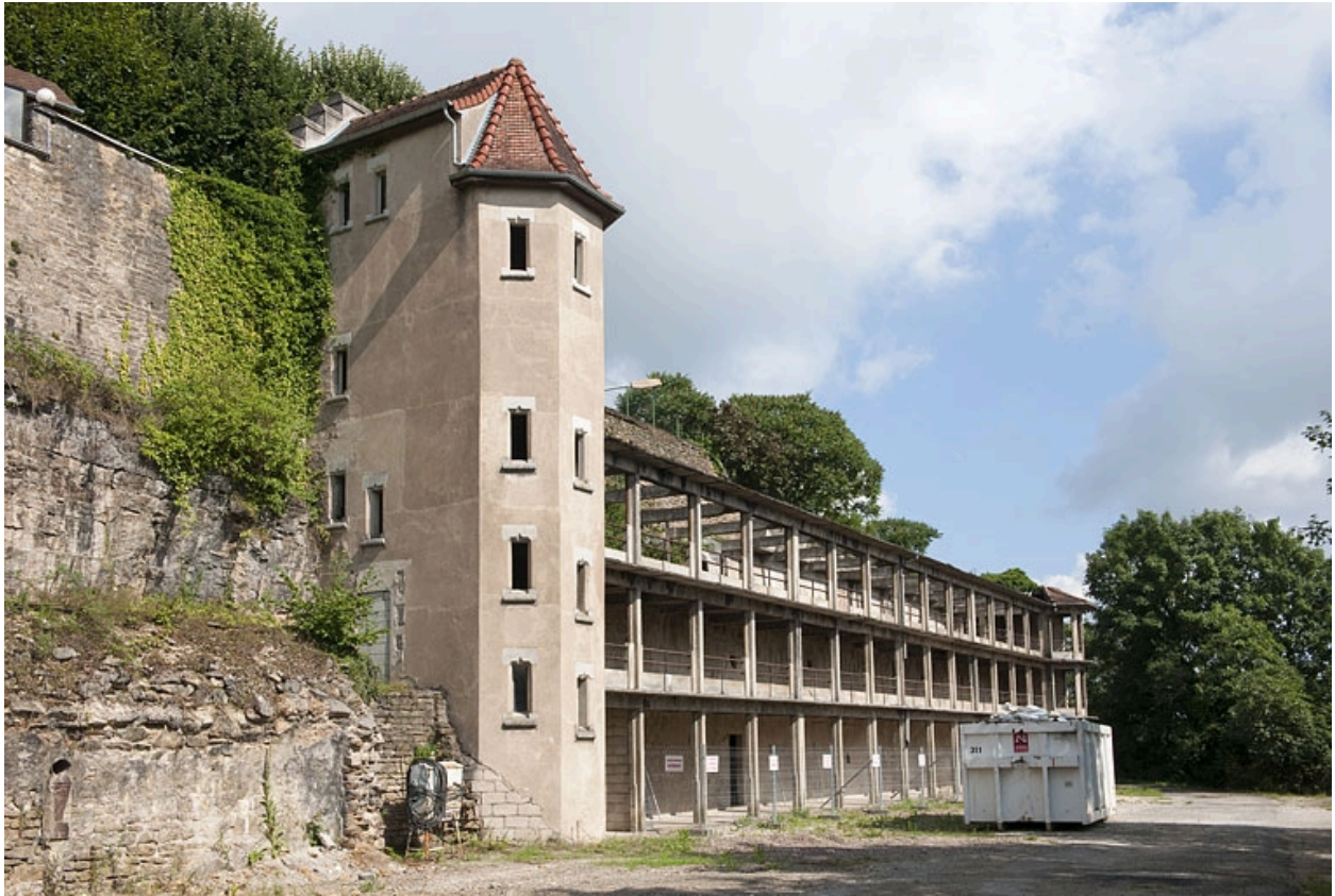
Bâtiment (H), vue rapprochée de la galerie.
