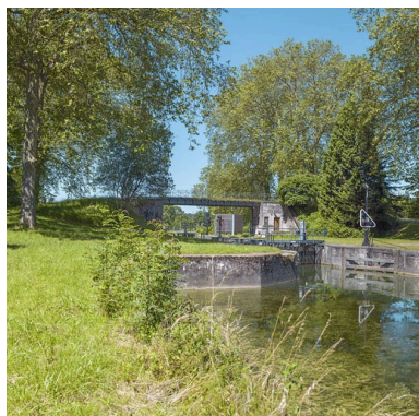
Vue d'ensemble du pont, depuis l'aval.
