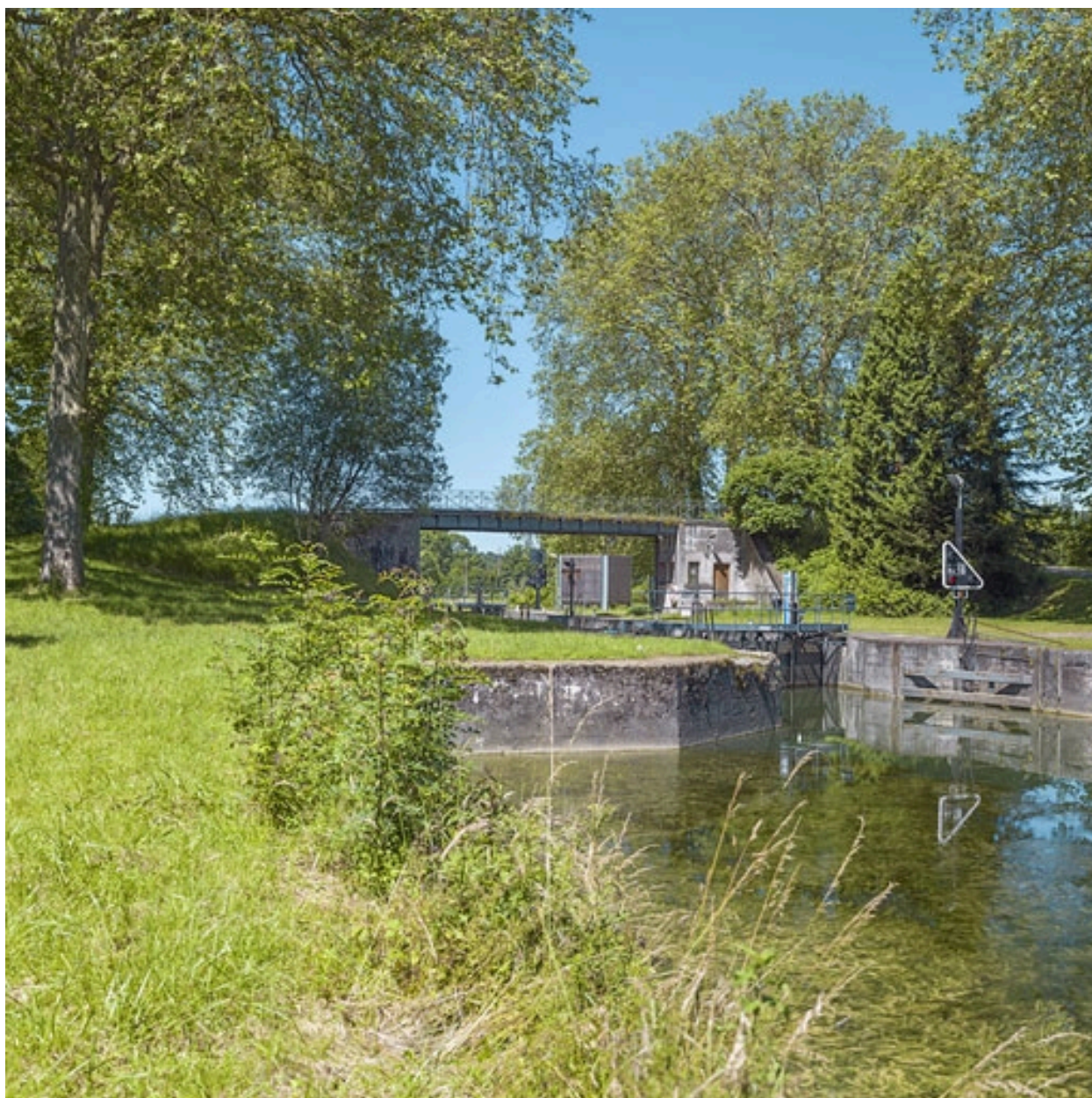
Vue d'ensemble du pont, depuis l'aval.
