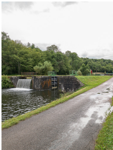
Vue du déversoir de superficie. Phot. Pierre-Marie Barbe-Richaud IVR26_20175800251NUC2A
