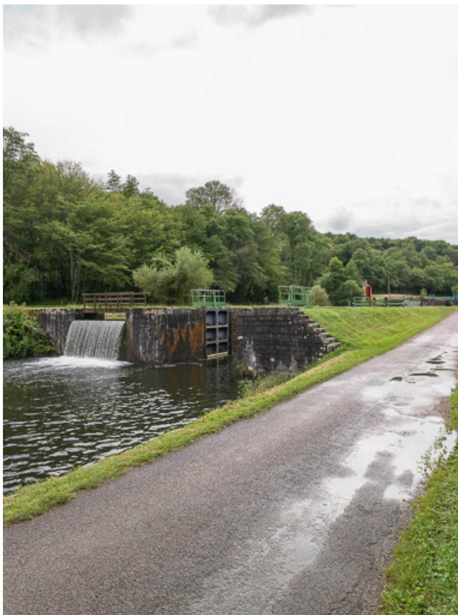
Vue du déversoir de superficie.
