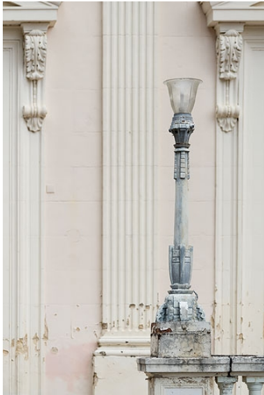
Candélabre devant la façade. Phot. Pierre-Marie Barbe-Richaud IVR26_20205800605NUC4A
