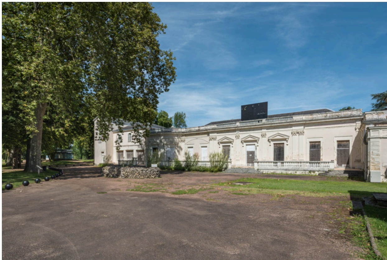
Façade, vue depuis le sud-ouest.
