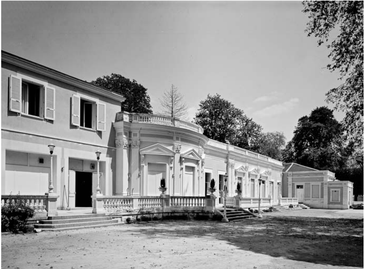
Façade, vue depuis le nord-ouest.
