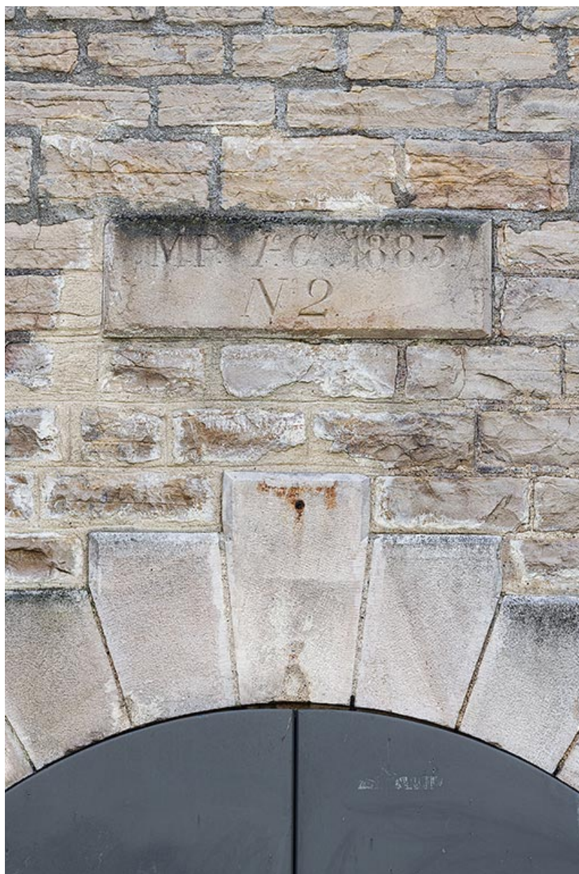
Site de l'ancien arsenal : magasin à poudre V2, date portée.
