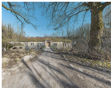
Le fort de Varois : front de gorge. Phot. Thierry Kuntz IVR26_20252100132NUC4A
