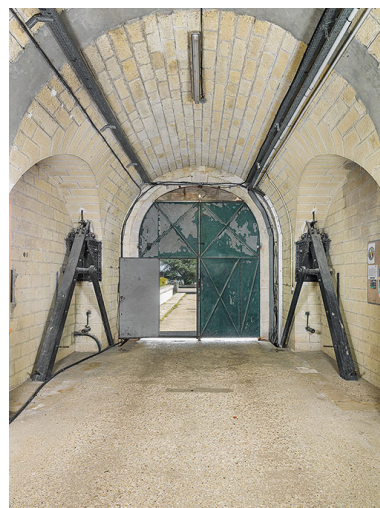
Le fort d'Hauteville : galerie d'entrée.
