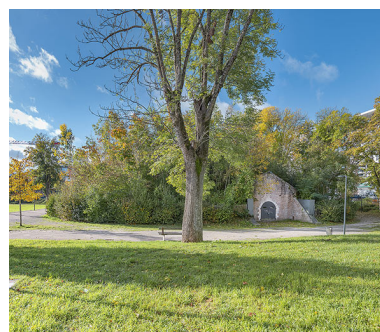
Site de l'ancien arsenal : magasin à poudre V2, vue de trois quarts. Phot. Thierry Kuntz IVR26_20252100289NUC4A
