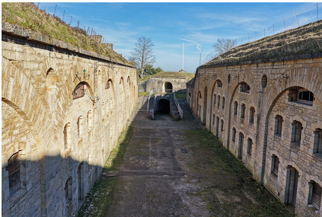
Le fort de la Motte-Giron : la cour de casernement. (vue aérienne).
