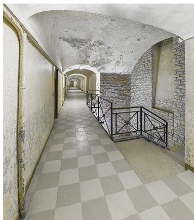
Le fort d'Hauteville : étage du casernement. Phot. Thierry Kuntz IVR26_20252100448NUC4A
