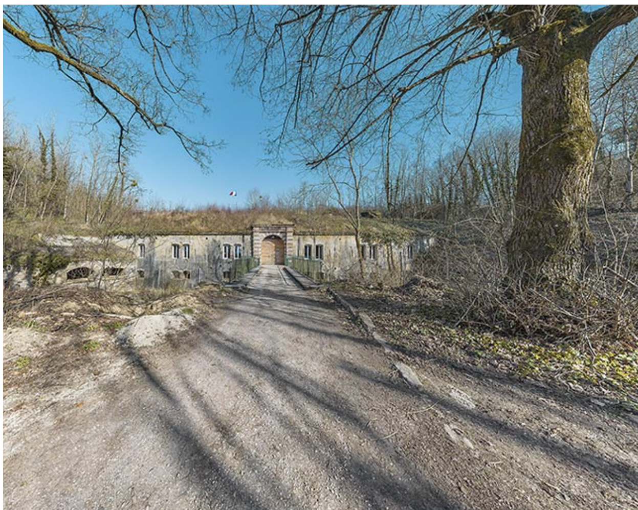
Le fort de Varois : front de gorge.
