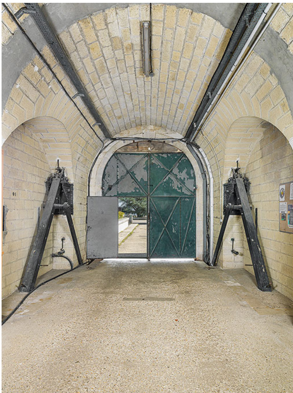
Le fort d'Hauteville : galerie d'entrée.
