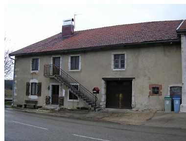
Ferme située au lieu-dit Les Brenets.
