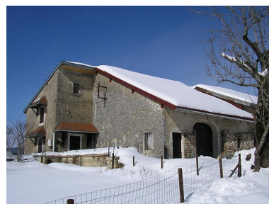
Ferme située au lieu-dit Sur le Moulin.
