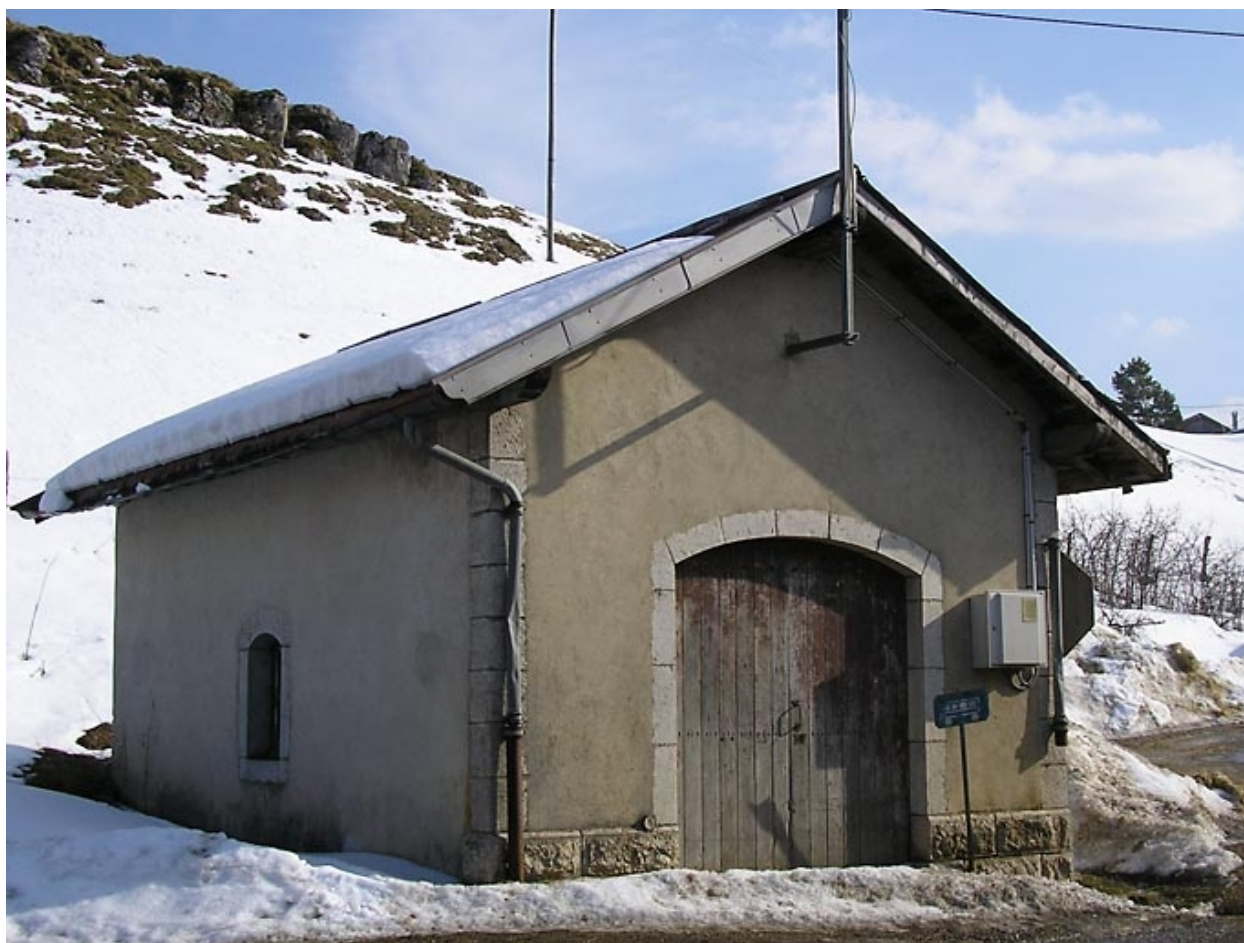
Remise de matériel incendie située au lieu-dit Les Chauvins.
