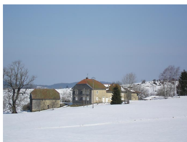
Moulin, scierie, ferme au lieu-dit Le Moulinet. Phot. Marie-Pierre Reynet IVR43_20083900237NUC1A
