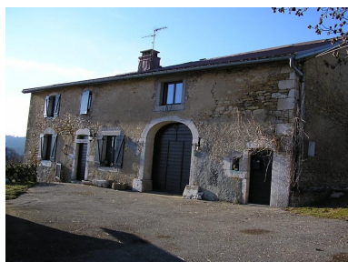
Ferme située au lieu-dit Les Brenets.
