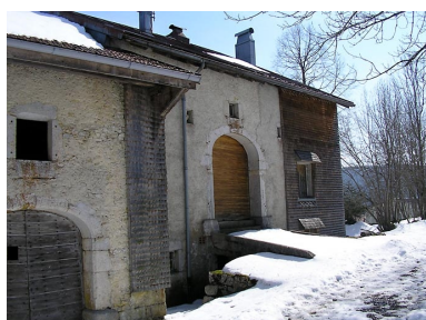
Ferme située au lieu-dit Les Jeannez.
