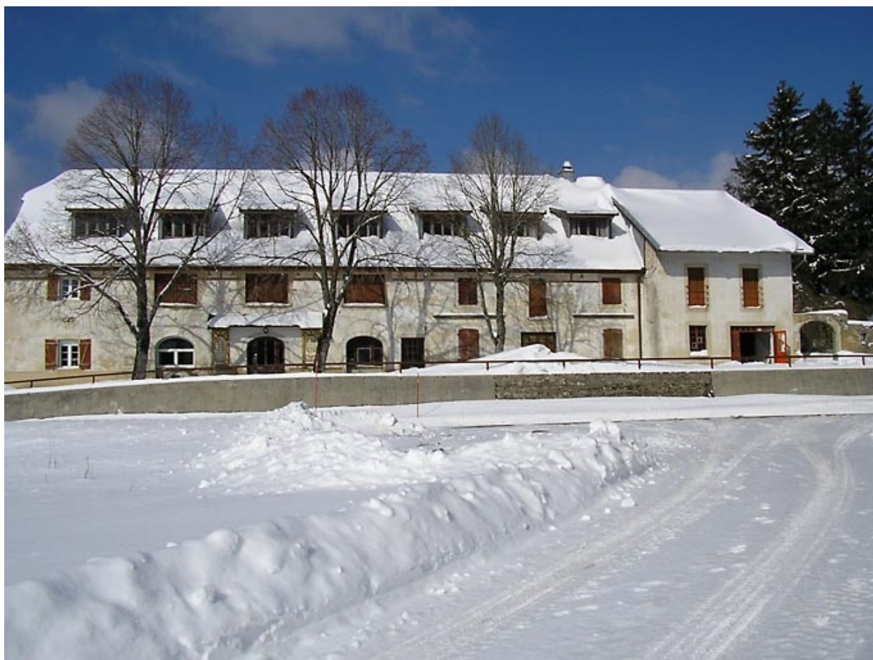
Etablissement conventuel, puis colonie de vacances des Perrets, actuellement maison, situé au lieu-dit Les Perrets.
