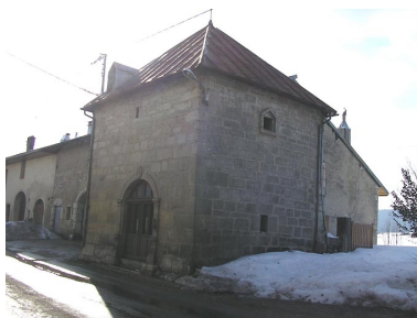
Chapelle Notre-Dame Libératrice située au lieu-dit Les Chauvins. Phot. Marie-Pierre Reynet IVR43_20083900266NUC1A
