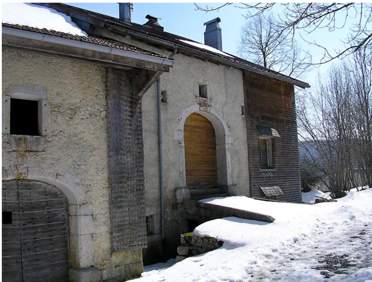
Ferme située au lieu-dit Les Jeannez.
