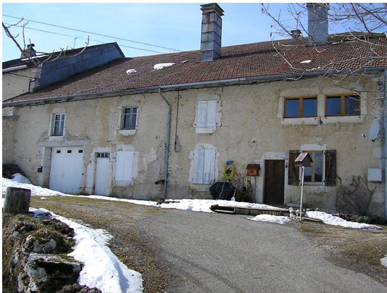
Ferme située au lieu-dit Les Jeannez.
