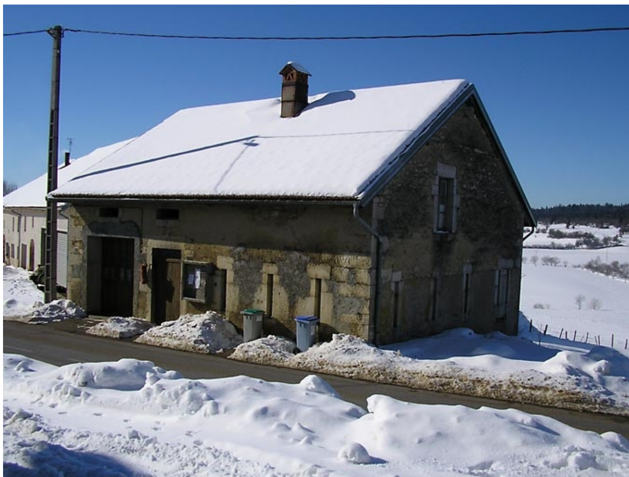
Fromagerie située au lieu-dit Les Bez.
