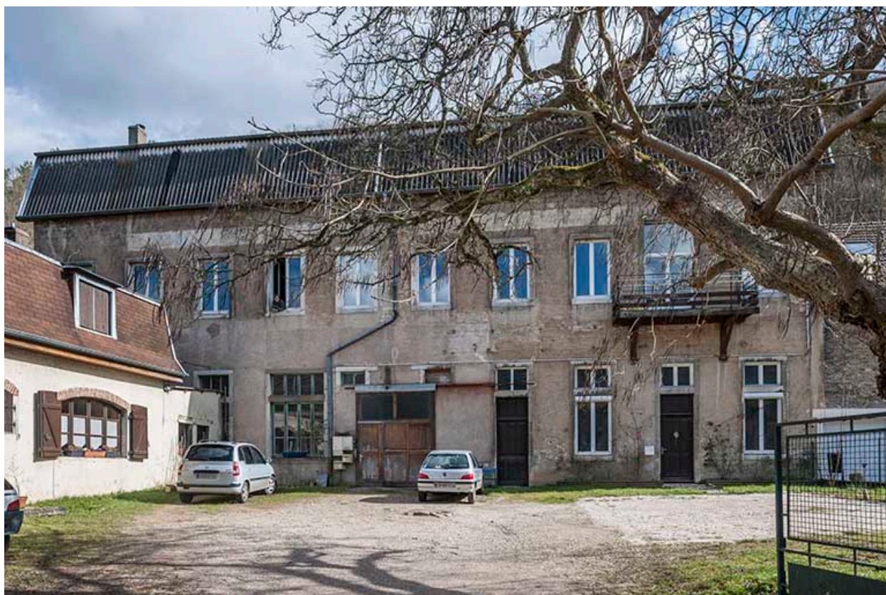
Façade antérieure de l'atelier de fabrication.
