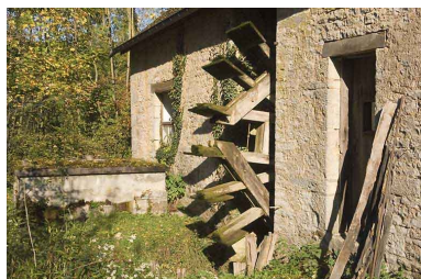
Façade postérieure. Détail de la roue. Phot. Jérôme Mongreville IVR43_20087000984NUC2A
