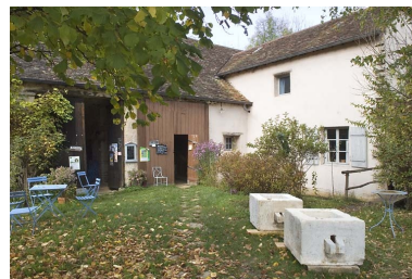
Façade est du moulin et logement. Phot. Jérôme Mongreville IVR43_20087000968NUC2A
