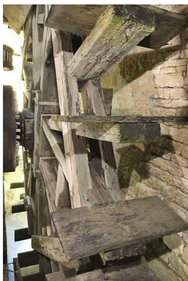
Détail de la roue hydraulique. Phot. Jérôme Mongreville IVR43_20087000974NUC2A
