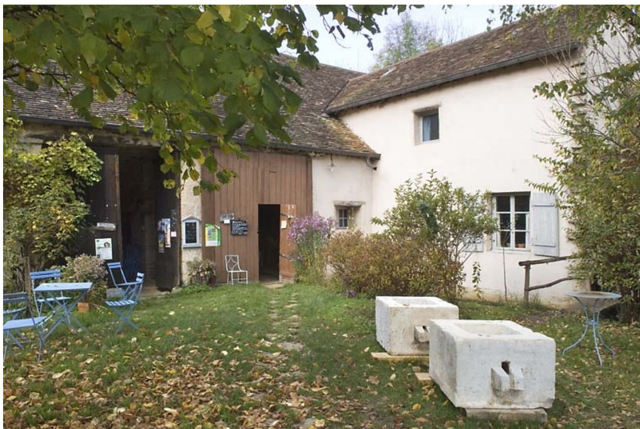
Façade est du moulin et logement.
