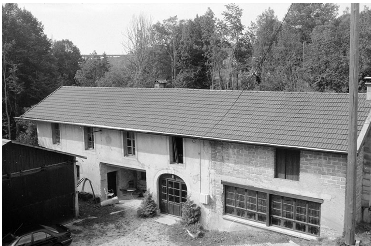
Façade antérieure des ateliers de fabrication.
