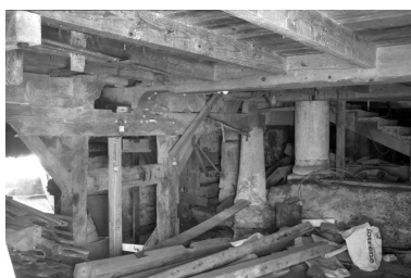
Transmission, support des meules et colonnes (2e étage de soubassement). Phot. Laurent Poupard IVR43_19913901268Z
