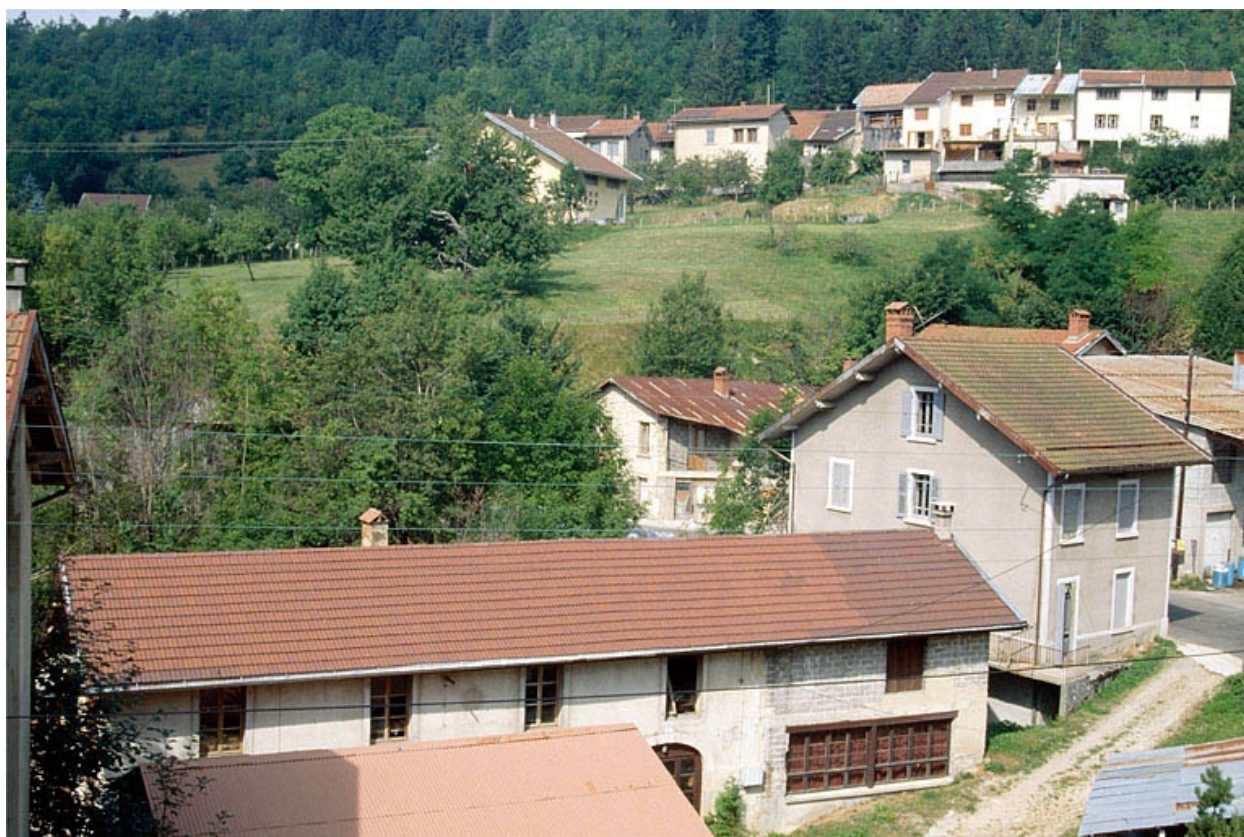
Ateliers de fabrication et logement.
