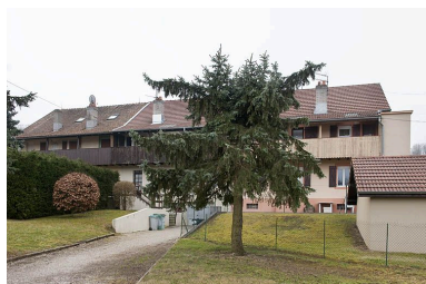
Immeuble (12 logements ?). Phot. Jérôme Mongreville IVR43_20122500188NUC4A
