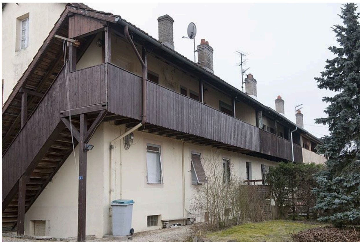
Immeuble (12 logements ?). Façade postérieure.
