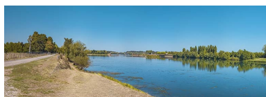
Vue d'ensemble des perrés et du barrage d'Ormes en arrière-plan. Phot. Thierry Kuntz IVR26_20207100426NUC4A
