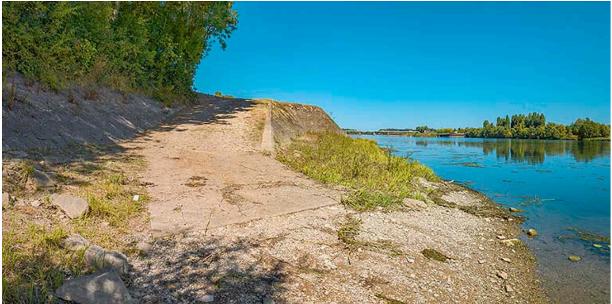
Rampe et perrés de la Mare-Jandeau.
