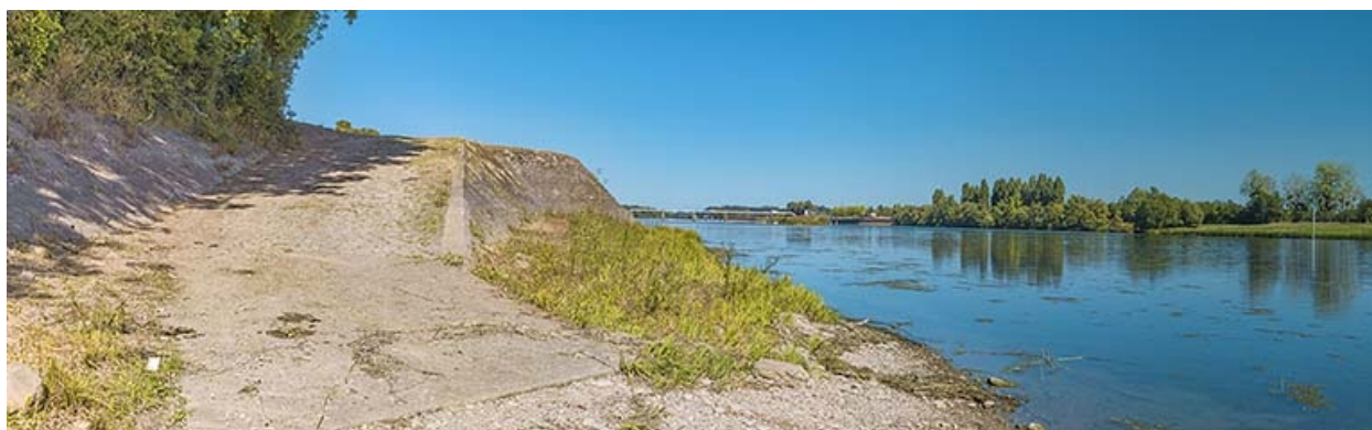
Rampe et perrés de la Mare-Jandeau.
