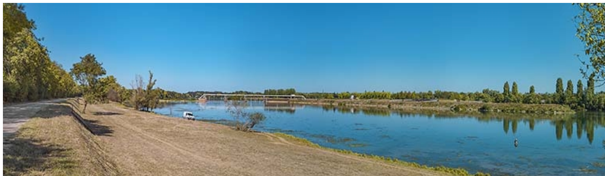
Les perrés et le barrage d'Ormes.
