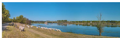
Vue d'ensemble des perrés et du barrage d'Ormes en arrière-plan. Phot. Thierry Kuntz IVR26_20207100423NUC4A
