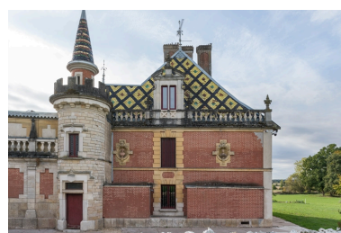
Elévation latérale droite (nord). Phot. Pierre-Marie Barbe-Richaud IVR26_20222100882NUC4A
