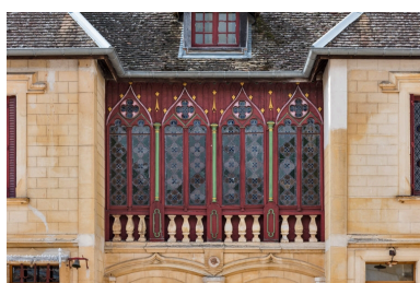
Elévation antérieure : galerie à l'étage. Phot. Pierre-Marie Barbe-Richaud IVR26_20222100917NUC4A
