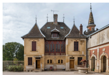
Elévation antérieure (est). Phot. Pierre-Marie Barbe-Richaud IVR26_20222100914NUC4A
