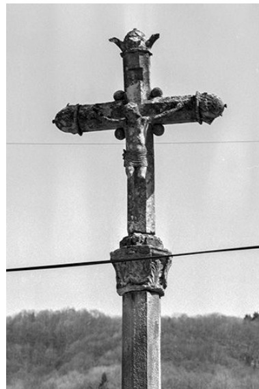
Partie supérieure, vue de face. Phot. Jérôme Mongreville IVR43_19853900150X
