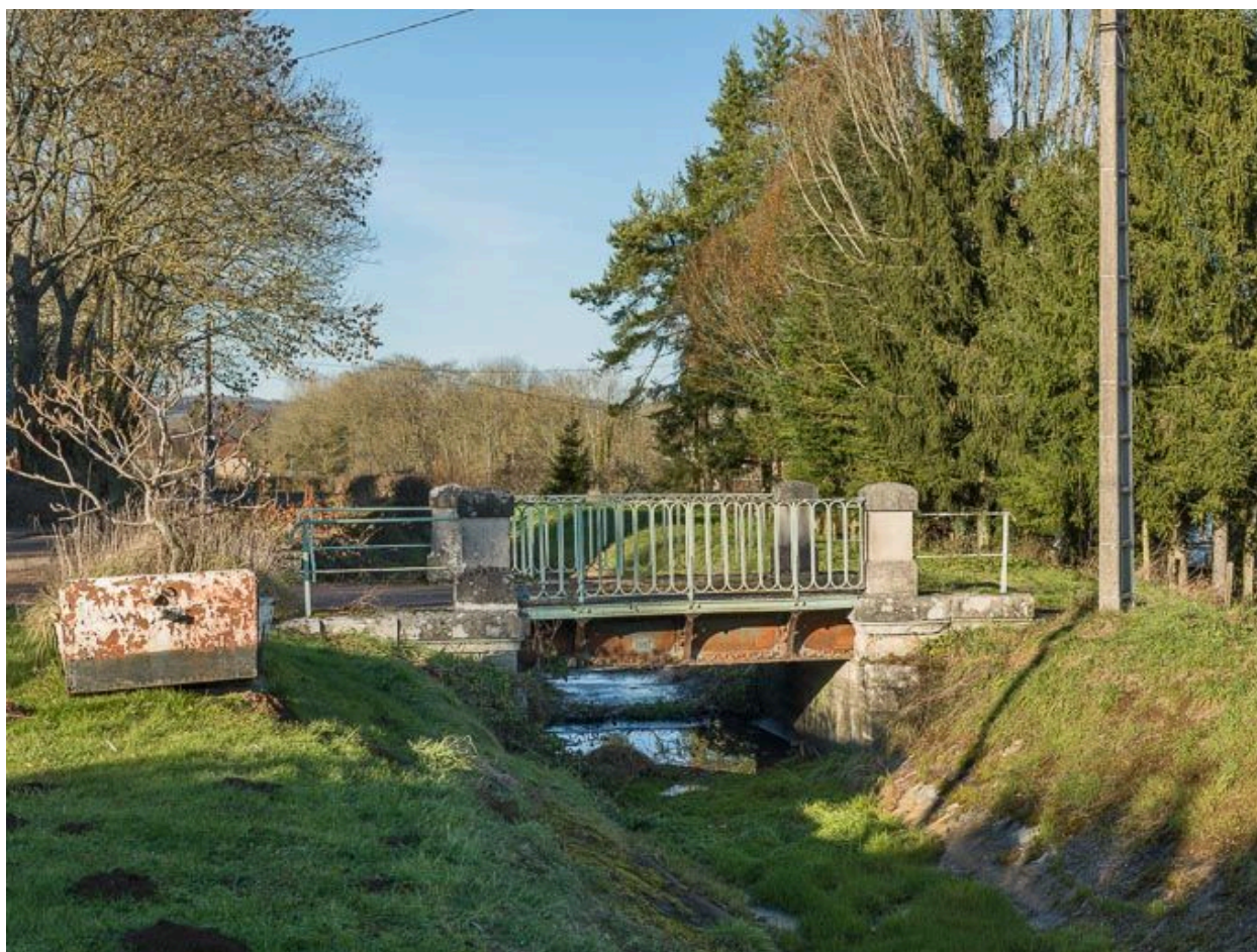
Vue d'ensemble du pont.
