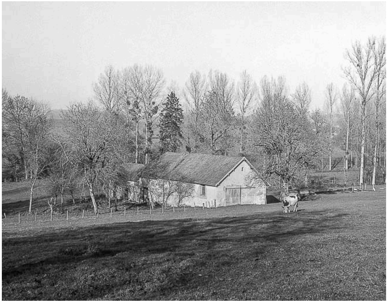
Vue d'ensemble éloignée du revers des bâtiments.
