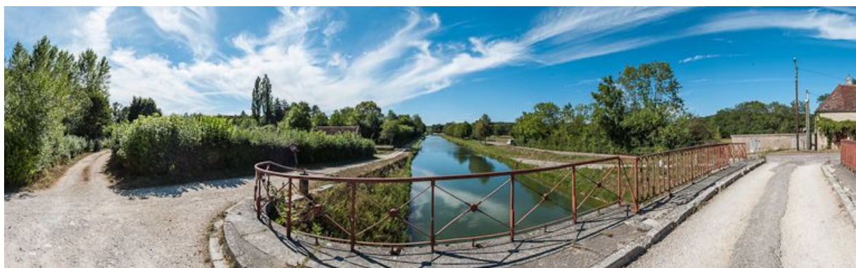
Le canal vu du pont.
