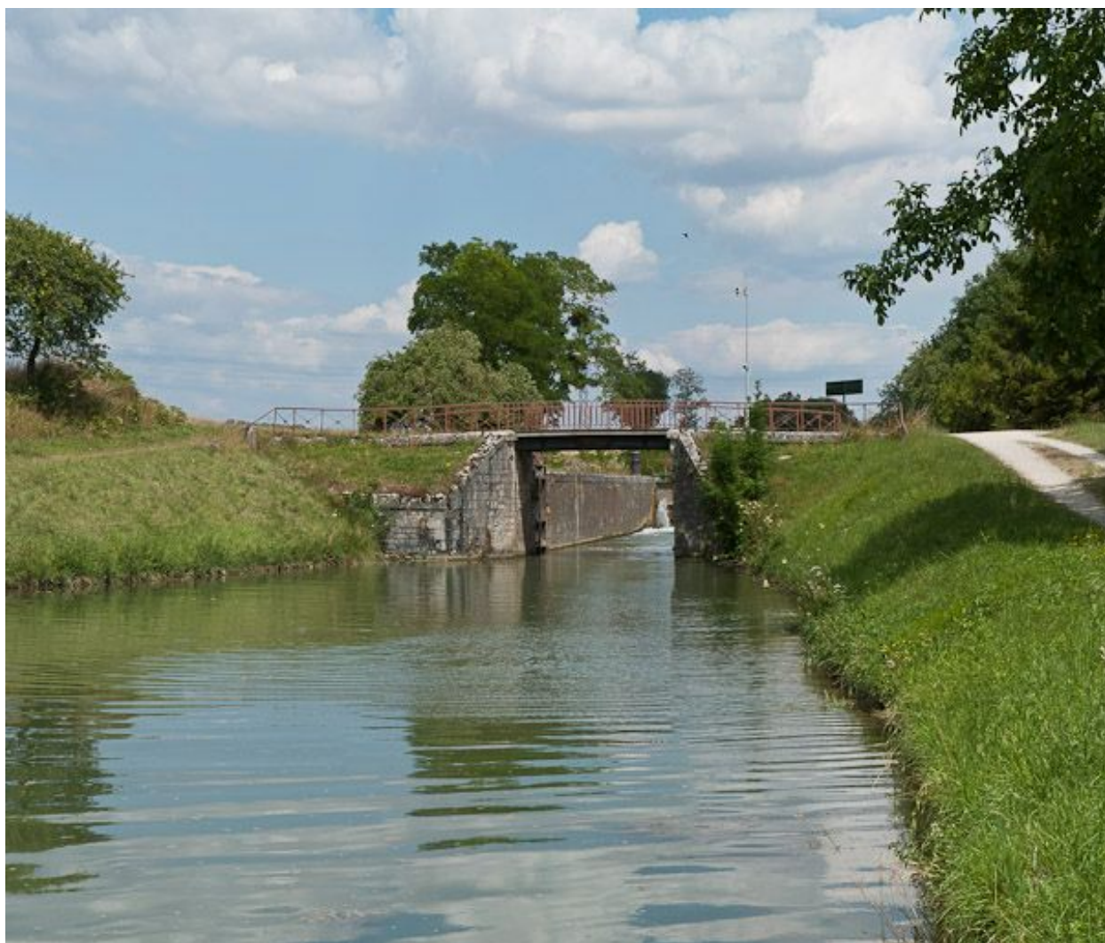
Vue du pont depuis l'aval.
