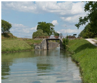
Vue du pont depuis l'aval. Phot. Pierre-Marie Barbe-Richaud IVR26_20118900282NUC2AQ
