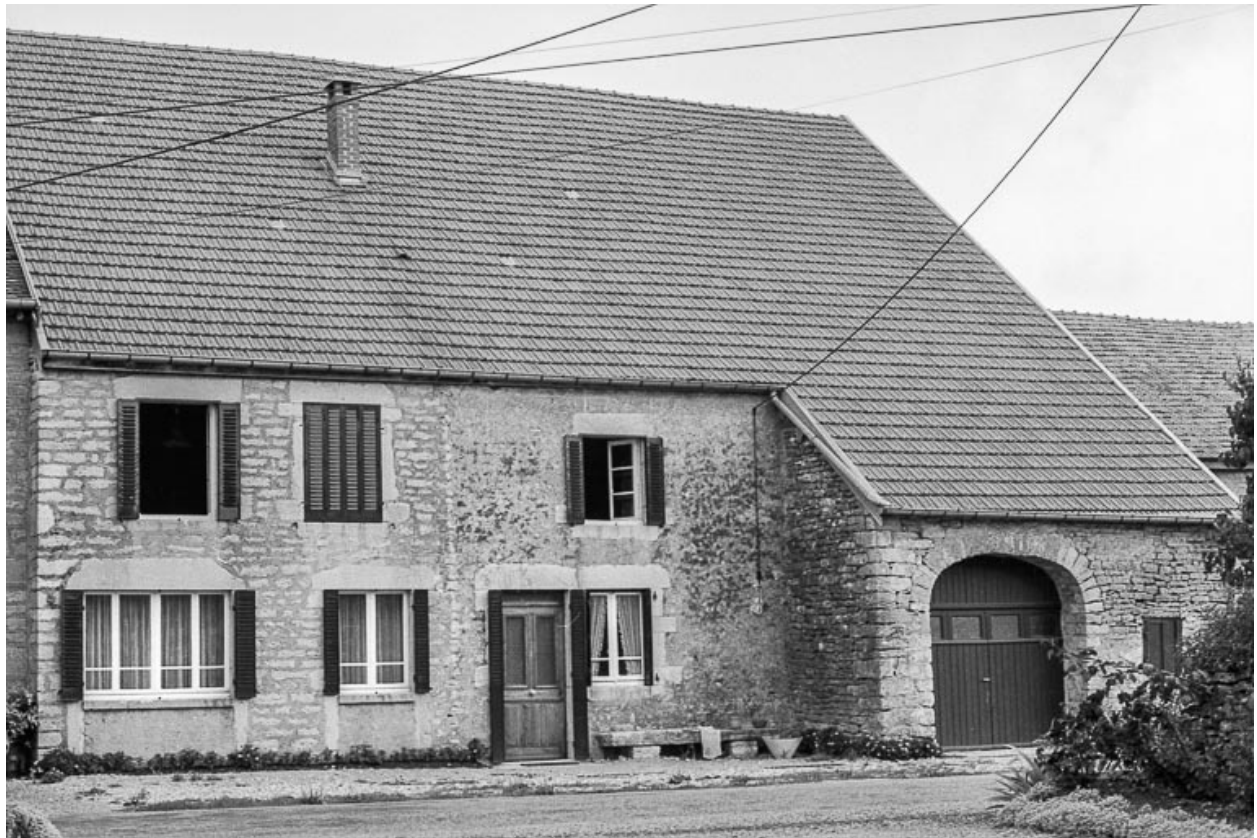
Ferme cadastrée B2 167 : façade antérieure.
