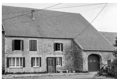
Ferme cadastrée B2 167 : façade antérieure. Phot. Bernard Pontefract IVR43_19763900229Z
