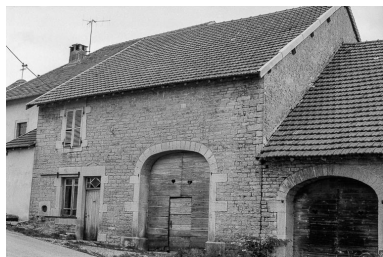
Ferme cadastrée B2 124 (droite) : façade antérieure. Phot. Bernard Pontefract IVR43_19763900237Z
