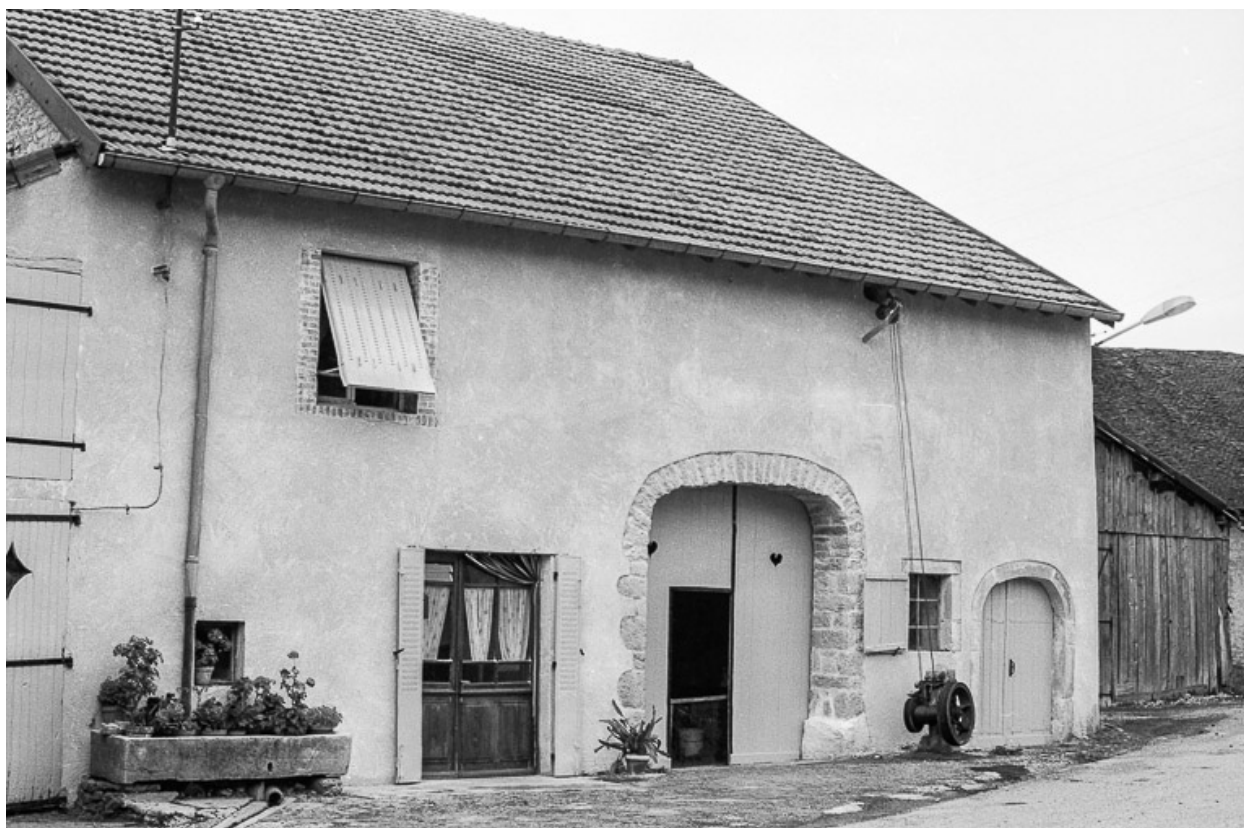
Ferme cadastrée B2 113 : façade antérieure.
