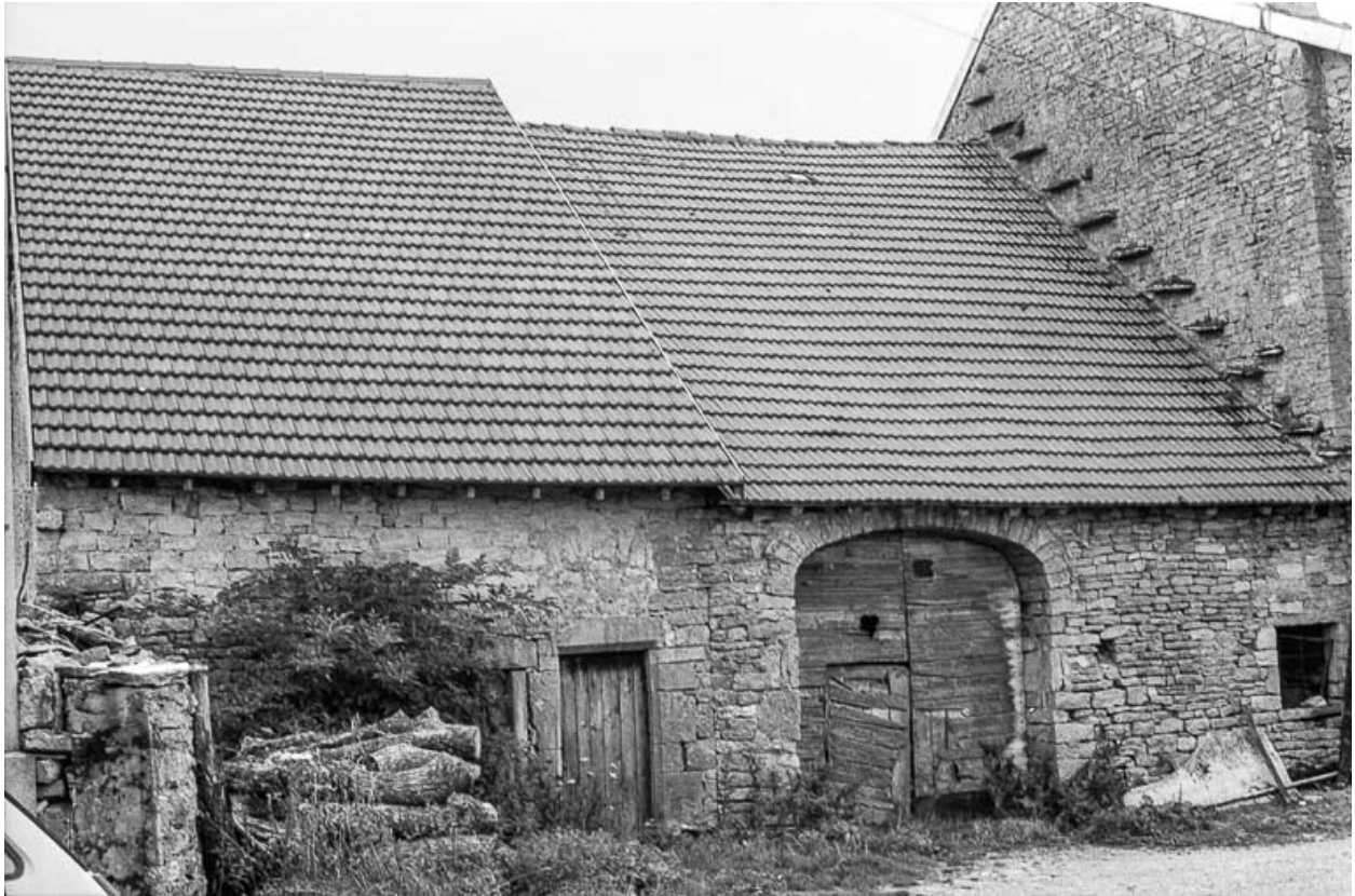
Ferme cadastrée B2 176 : façade postérieure.
