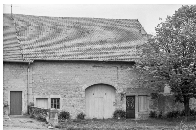
Ferme cadastrée B2 181 : façade antérieure. Phot. Bernard Pontefract IVR43_19763900233Z
