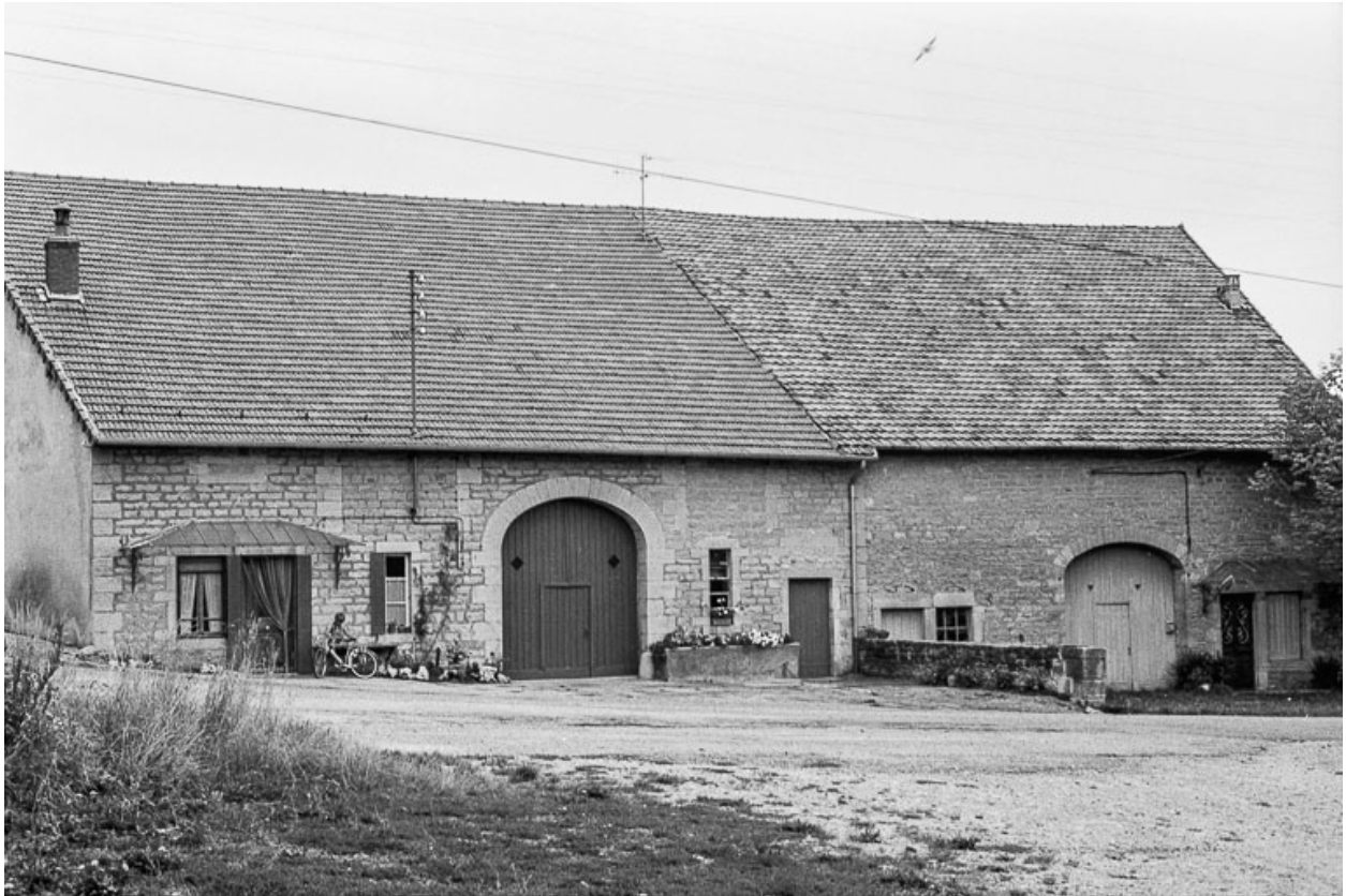
Ferme cadastrée B2 181 et 182 : façades antérieures.
