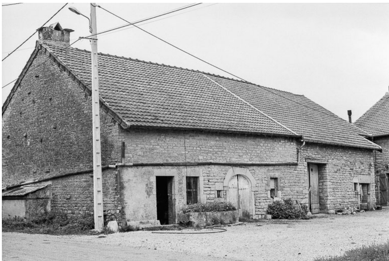
Ferme cadastrée B2 157 : façade sur rue.
