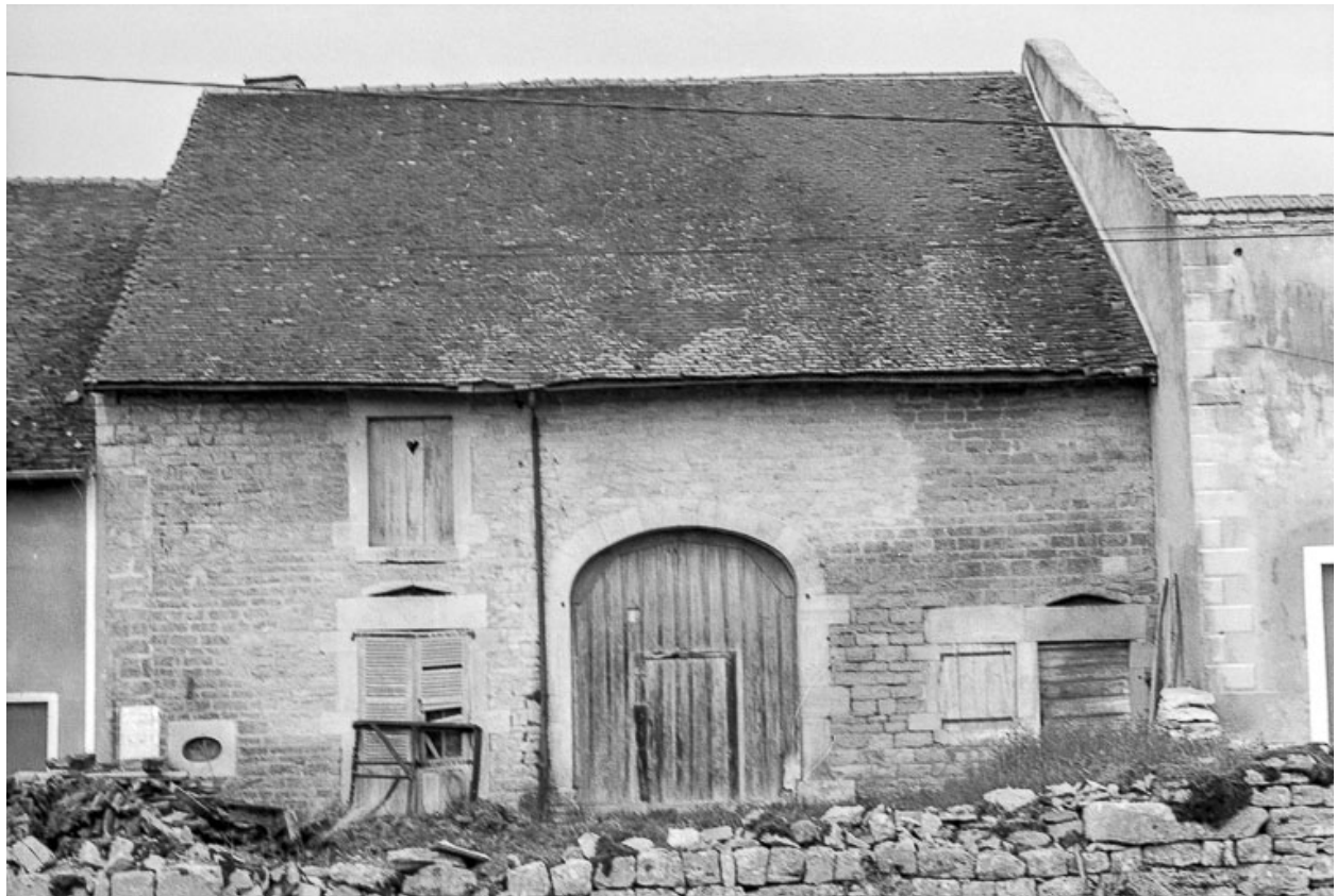
Ferme cadastrée B2 134 : façade postérieure (?).
