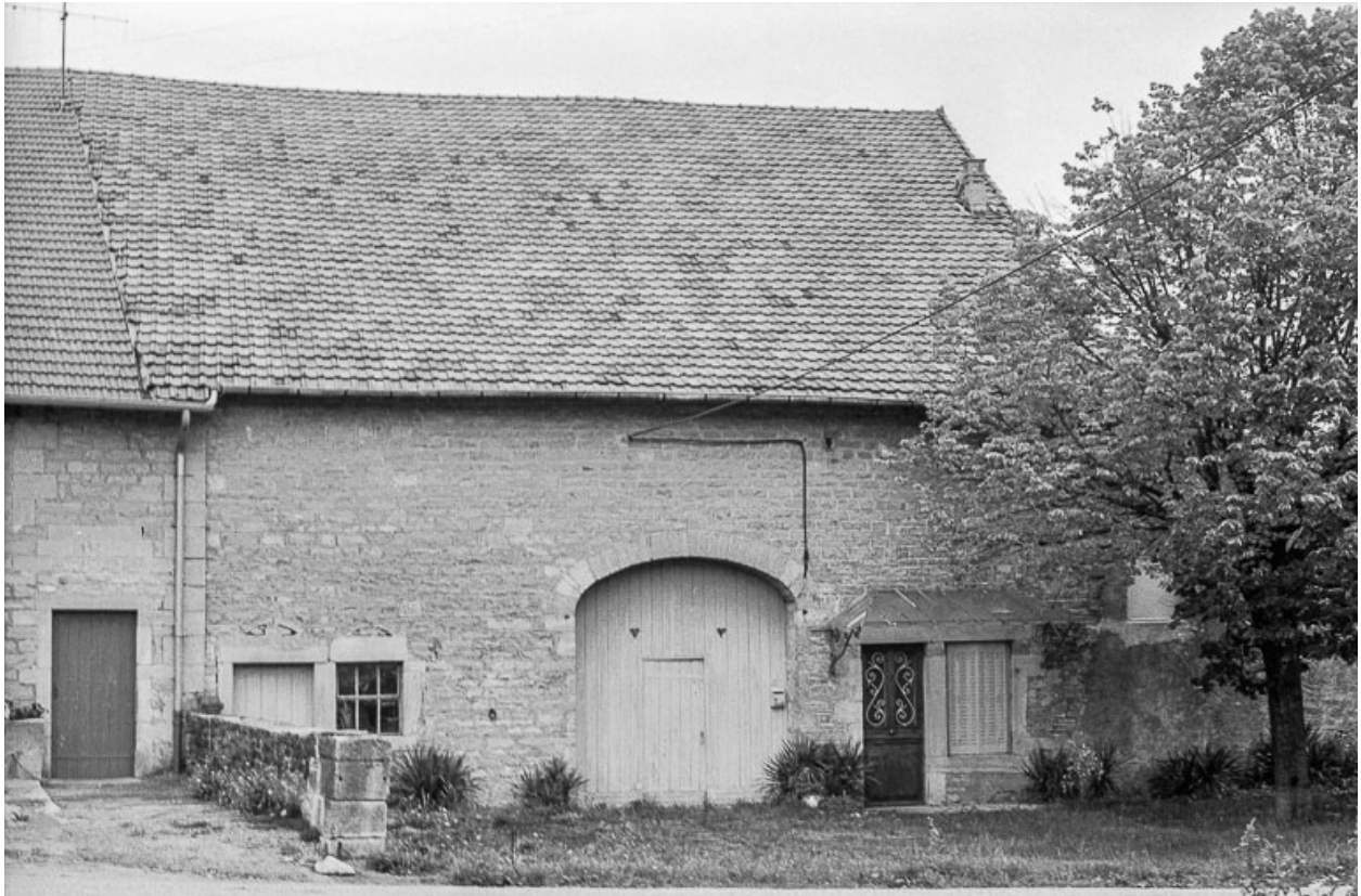
Ferme cadastrée B2 181 : façade antérieure.
