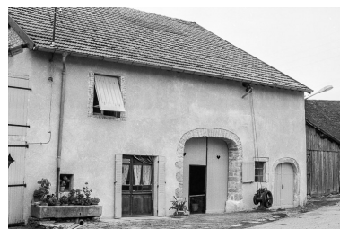
Ferme cadastrée B2 113 : façade antérieure. Phot. Bernard Pontefract IVR43_19763900236Z
