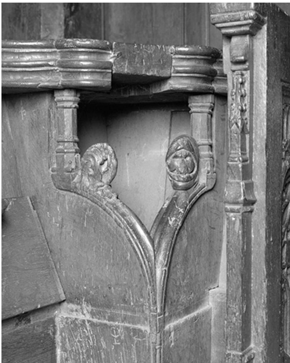
Stalles sud, parcloles ouest de la stalle 1 et parclose en retour.
