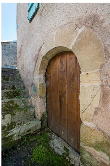
Entrée de cave. Phot. Jérôme Mongreville IVR43_20187000092NUC4A
