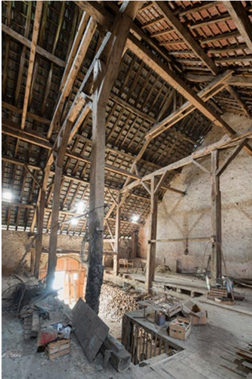
Charpente de la ferme, vue du grenier, 13 Grande rue.
