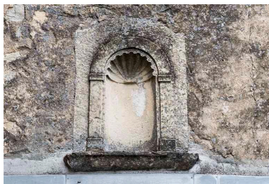
Niche située au-dessus de la porte d'entrée de l'habitation, 13 Grande rue. Phot. Jérôme Mongreville IVR43_20167001494NUC4A
