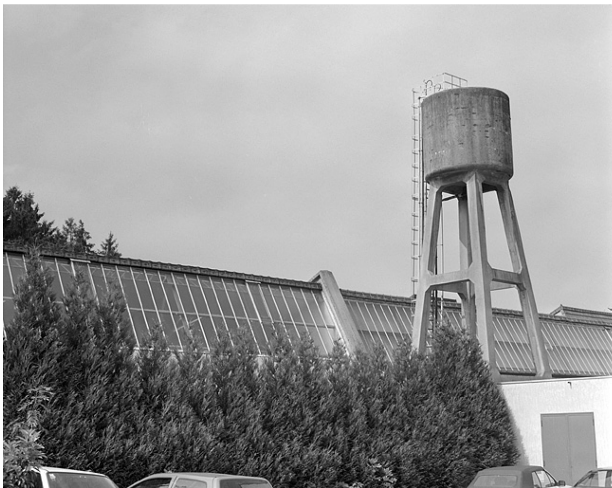
Atelier de fabrication et réservoir industriel.
