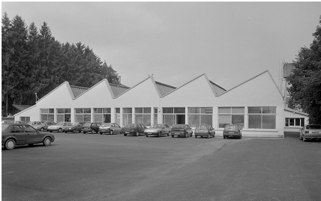
Atelier de fabrication depuis l'est.
