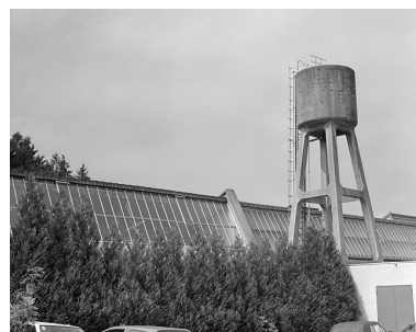
Atelier de fabrication et réservoir industriel. Phot. Jérôme Mongreville IVR43_19963900609X
