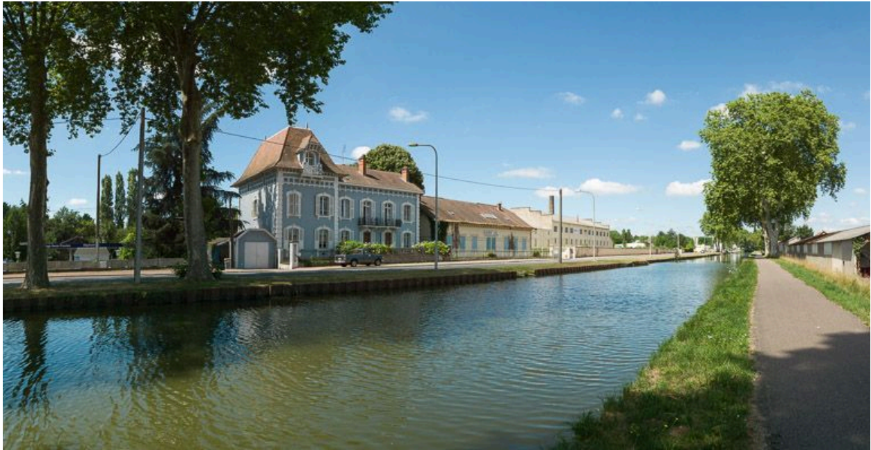
Les bâtiments de l'usine, rive gauche.
