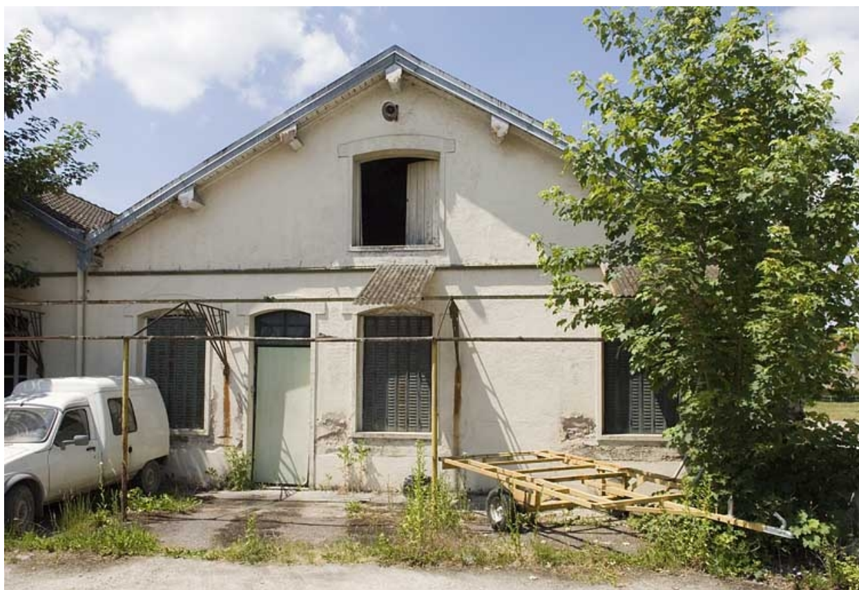
Bâtiment des bureaux (?).
