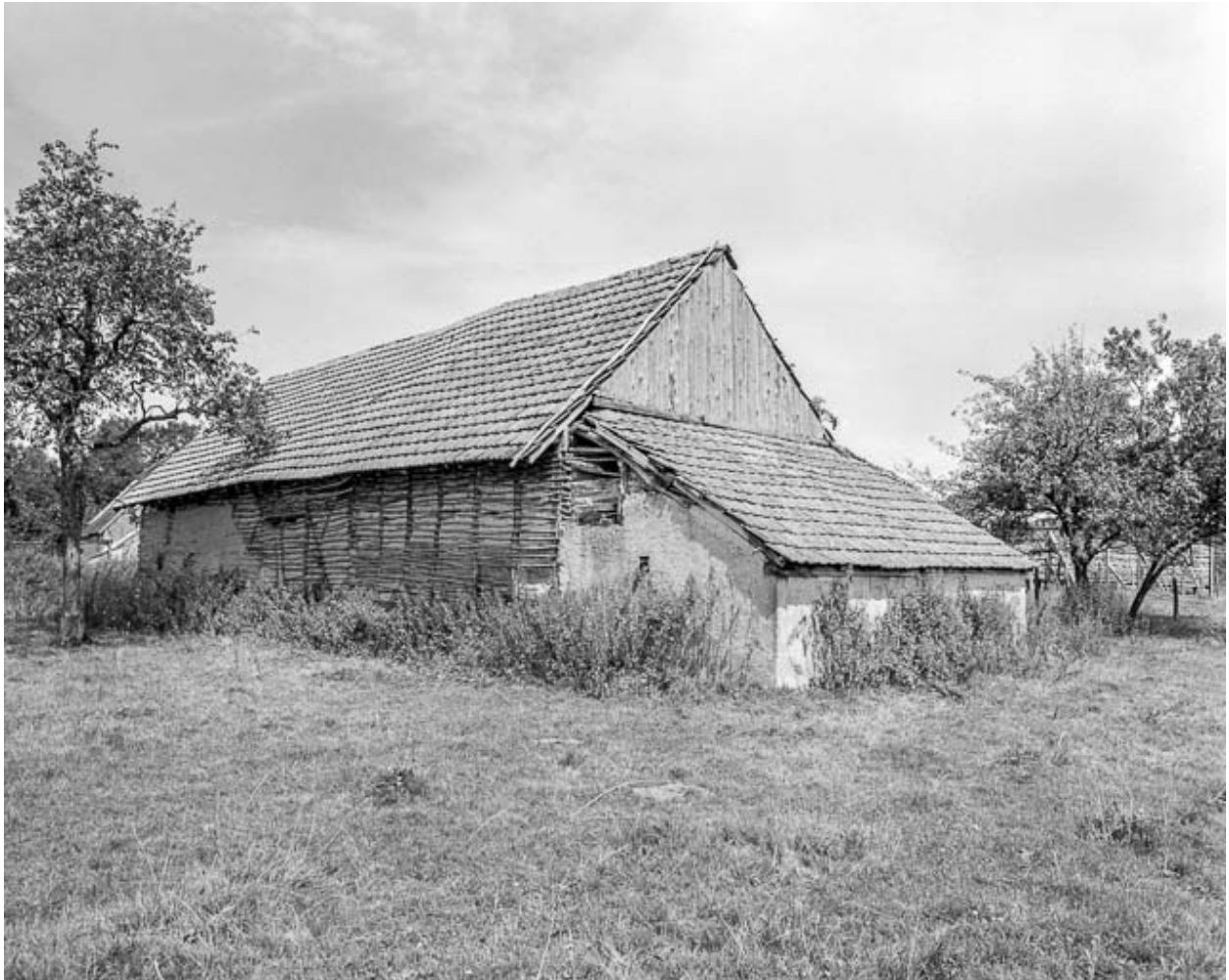
Ferme cadastrée 1963 AB 20 : façade postérieure.
