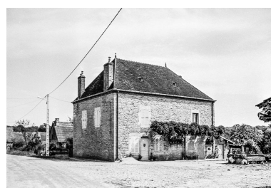
Ferme cadastrée 1683 AB, datée de 1817 : façade antérieure. Phot. Guy Forestier IVR43_19753900353Z
