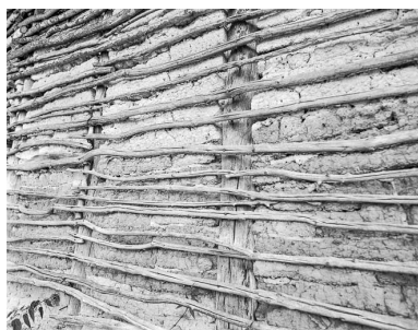
Ferme cadastrée 1963 AB 20 : matériau de façade. Phot. Dominique Dominguez IVR43_19773900073X
