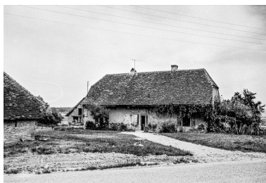
Ferme cadastrée 1963 AC : façade antérieure. Phot. Guy Forestier IVR43_19753900346Z
