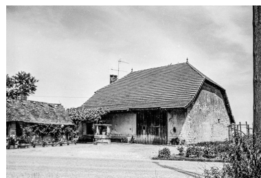
Ferme cadastrée 1963 AC : vue générale. Phot. Guy Forestier IVR43_19753900348Z
