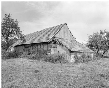
Ferme cadastrée 1963 AB 20 : façade postérieure. Phot. Dominique Dominguez IVR43_19773900071X
