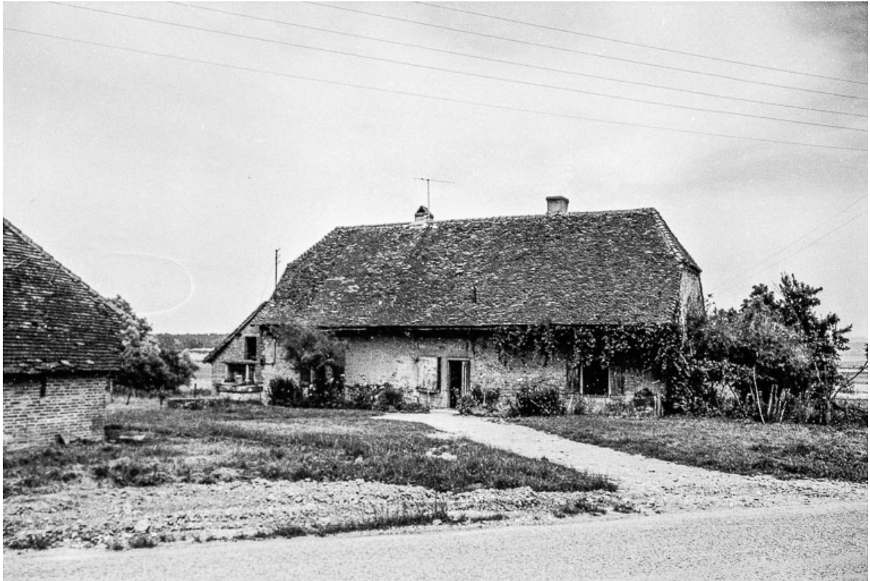
Ferme cadastrée 1963 AC : façade antérieure.
