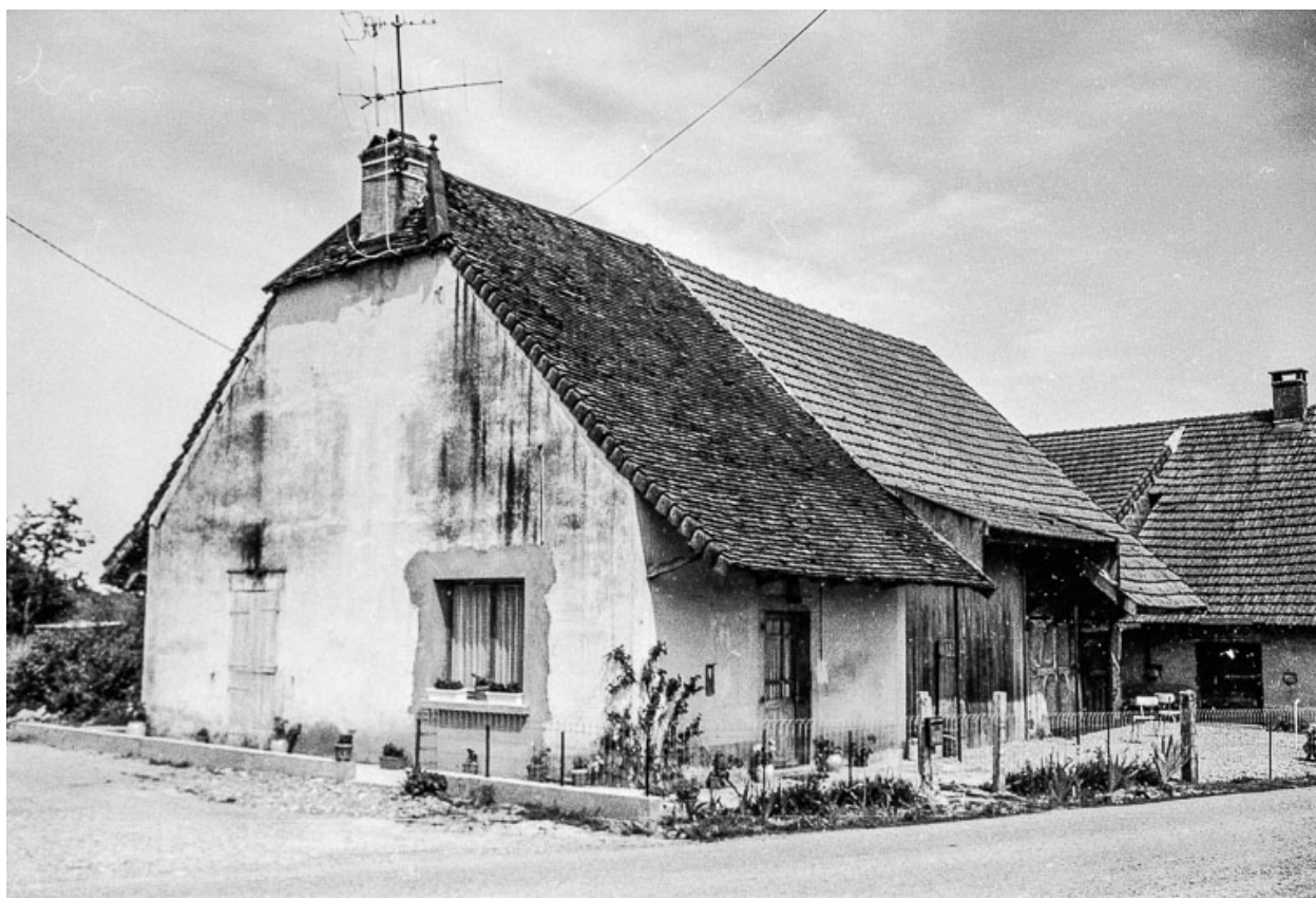
Ferme : façades et latérale droite.
