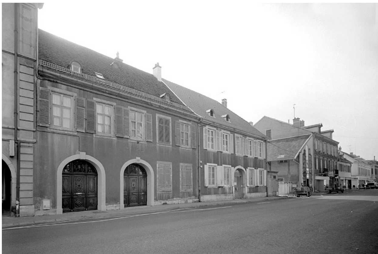
Vue d'ensemble avec la maison n° 63.
