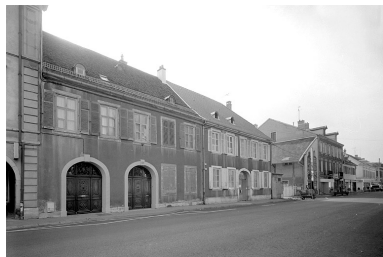
Vue d'ensemble avec la maison n° 63.
