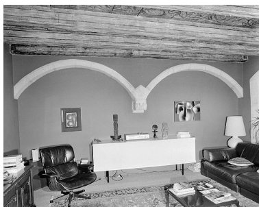
Arc double renforçant le mur de refend perpendiculaire à la façade sur rue dans la pièce principale au premier étage. Phot. Jérôme Mongreville IVR43_19872500306X
