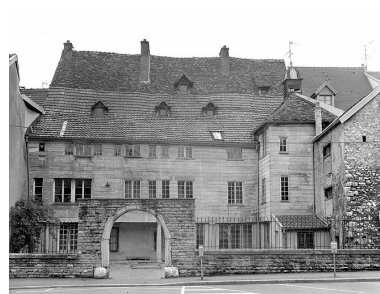
Façade sur cour. Phot. Jérôme Mongreville IVR43_19872500263V
