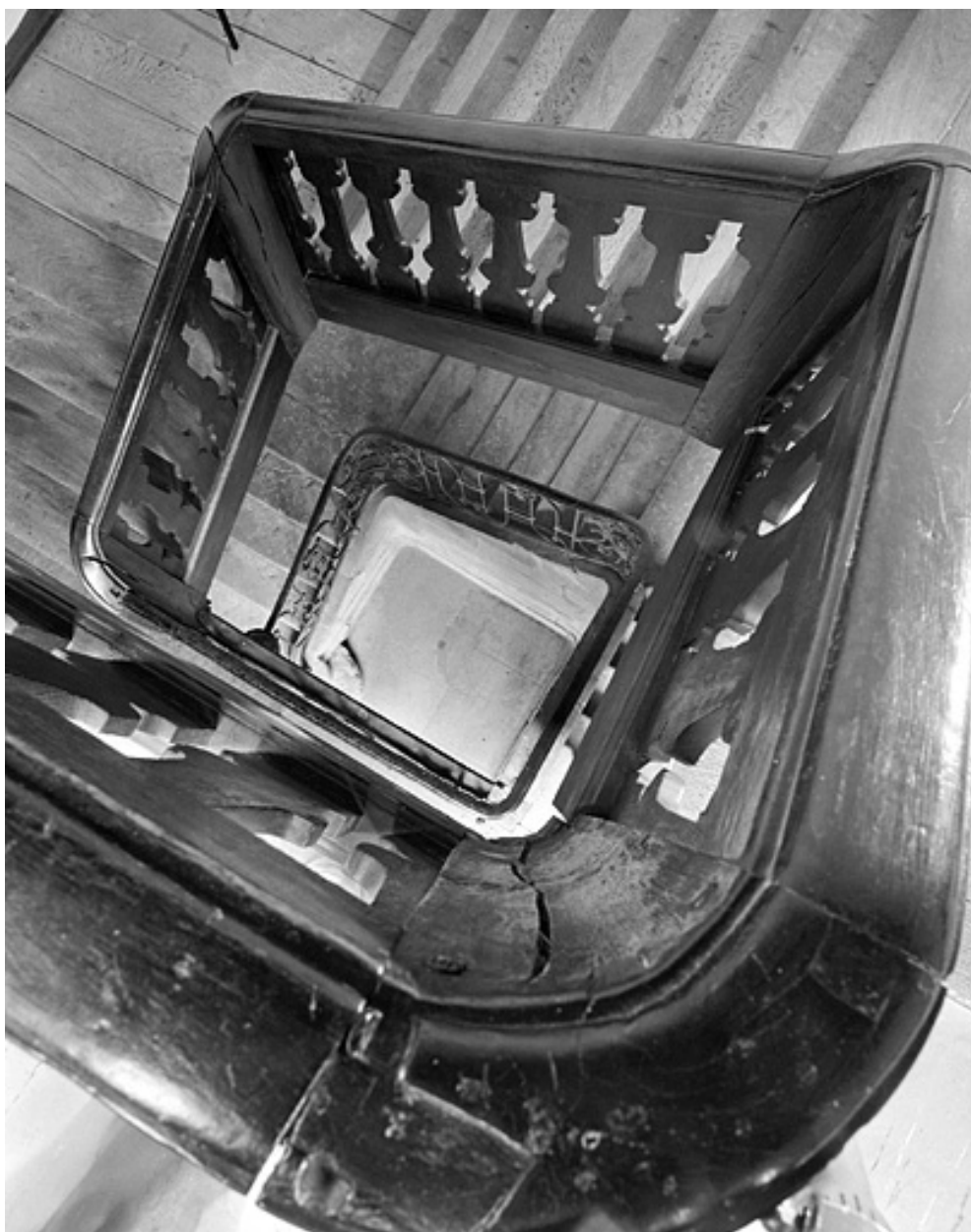
Escalier vu du deuxième étage.
