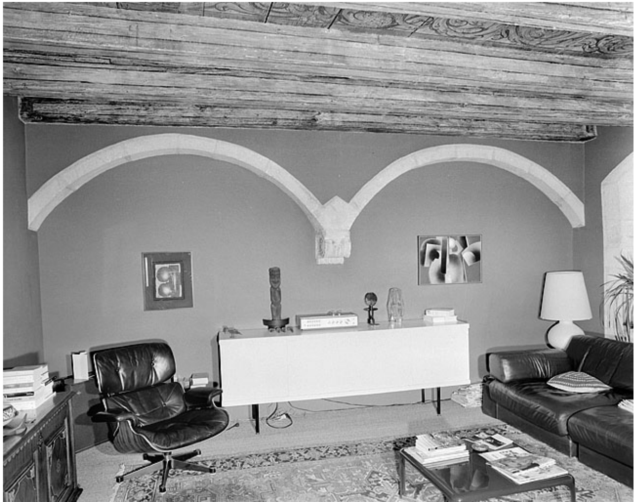
Arc double renforçant le mur de refend perpendiculaire à la façade sur rue dans la pièce principale au premier étage.
