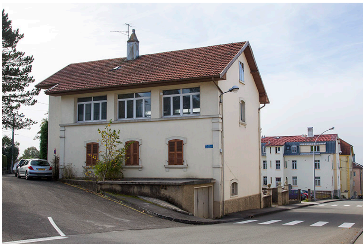
Façades postérieure et latérale gauche.
