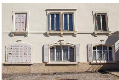
Façade antérieure : fenêtres du rez- de-chaussée et du premier étage. Phot. Yves Sancey IVR43_20132502425NUC2A
