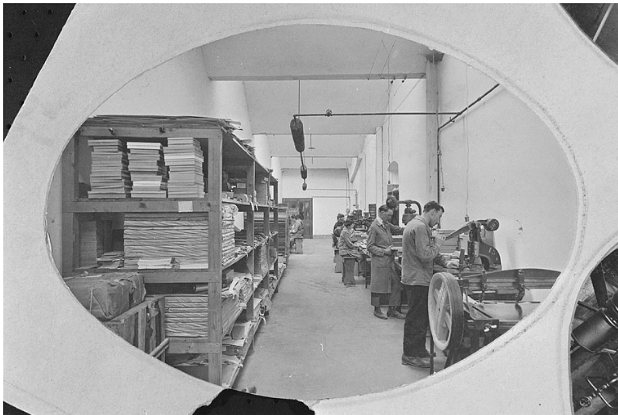
Vue ancienne de l'atelier de gainerie.
