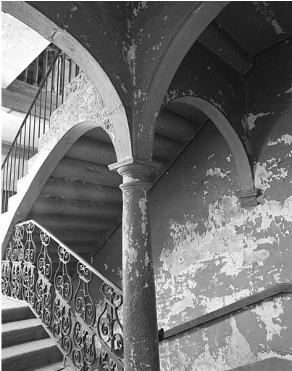
Escalier vu depuis le premier palier.
