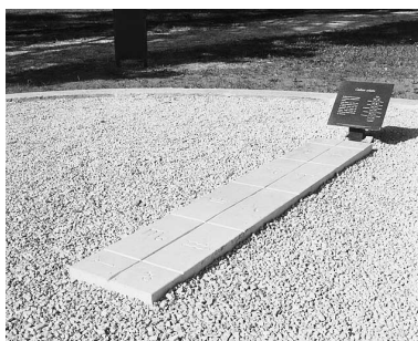
La dalle centrale, après restauration.
