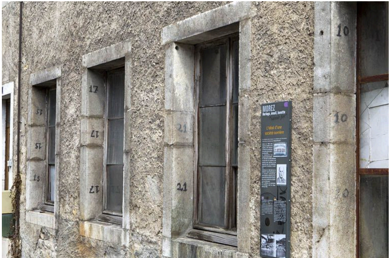
Chiffres peints sur les piédroits de fenêtres. Fenêtres de l'usine de lunetterie de la coopérative Les Lunetiers réunis, au 5 rue de la Concorde.
