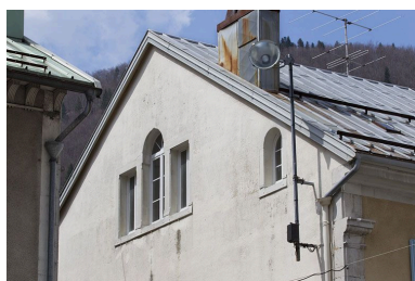
Maison de notable (19e siècle) au n° 116 rue de la République. serlienne. Maison (AI 461-462) bâtie en 1814. Phot. Yves Sancey IVR43_20103900166NUC2A
