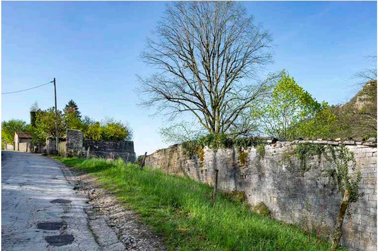
Rempart est, depuis le milieu du chemin de la Tour ronde.
