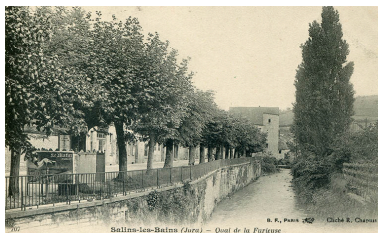
Salins-les-Bains (Jura) - Quai de la Furieuse, s.d. [fin 19e ou début 20e siècle]. Phot. R. Chapuis IVR43_20243900349NUC4A
