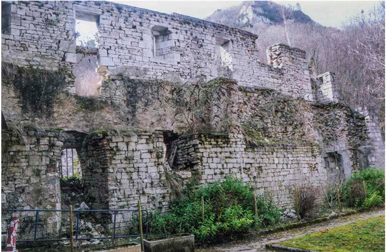
Face interne du rempart conservé au nord du pont Saint-Nicolas, 2011.
