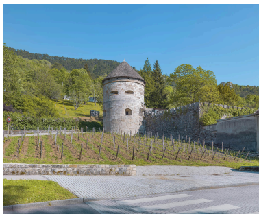
Tour d'Andelot et courtine nord.
