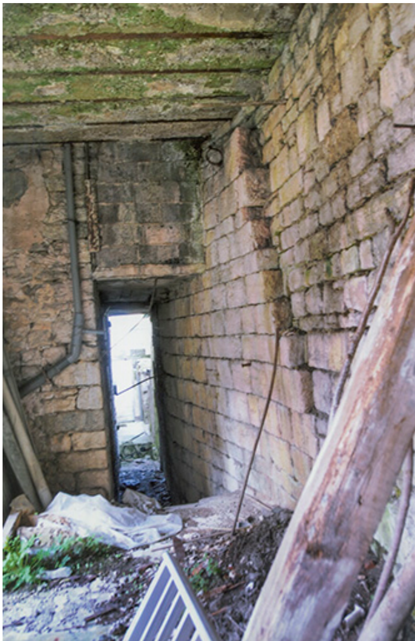
Parement de la courtine nord, rue des Corneux, 2011.
