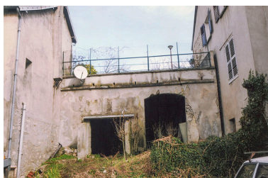
Constructions modernes adossées au mur de courtine nord, rue des Corneux, 2011. Phot. Patrick Blandin IVR43_20243900995NUC2A
