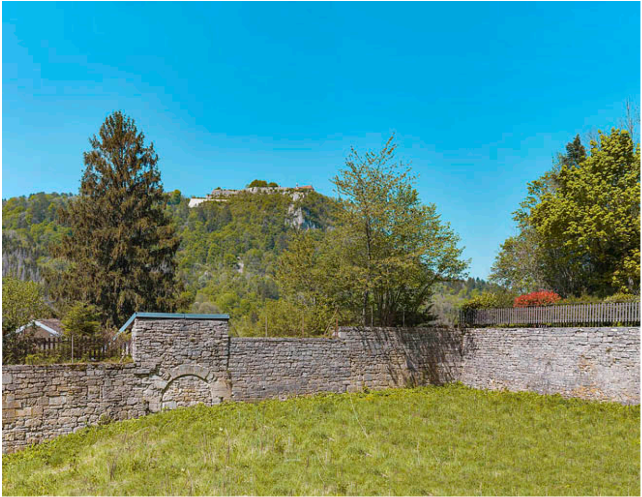
Rempart est, et poterne (murée) de Châtelguyon.
