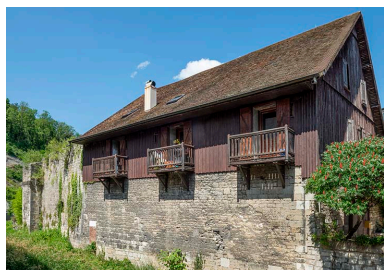
Rempart au nord de la porte Saint-Nicolas. Phot. Jérôme Mongreville IVR43_20233900953NUC4A
