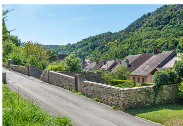
Tracé du mur d'enceinte est longeant le bas du chemin de la Tour ronde.
