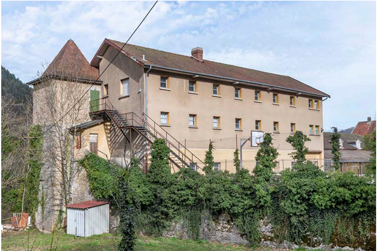
Tour Terrestre, accolée au pignon sud du bâtiment dit du Rayon de Soleil.
