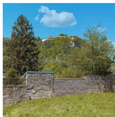
Poterne (murée) de Châtelguyon. Phot. Thierry Kuntz IVR43_20223900601NUC4A
