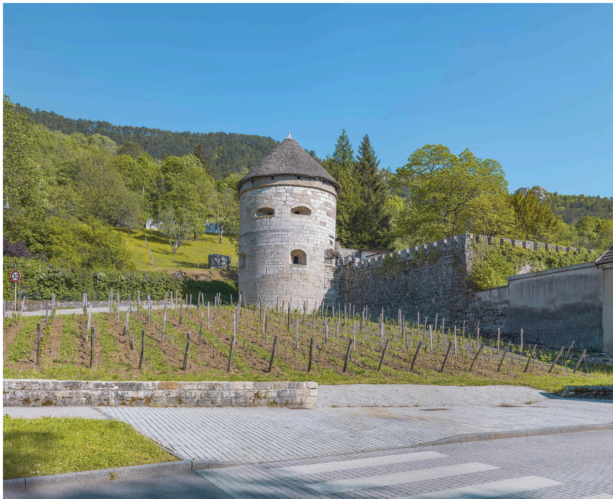
Tour d'Andelot et courtine nord.
