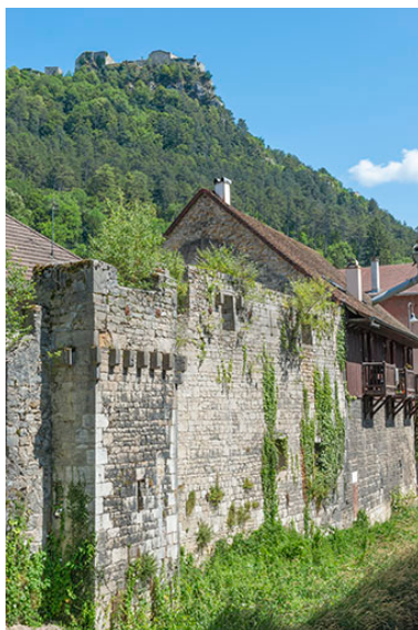
Rempart et tour en aval de la porte Saint-Nicolas. Phot. Jérôme Mongreville IVR43_20233900956NUC4A
