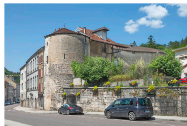
Tour est de la porte Oudin et mur du front sud. Phot. Jérôme Mongreville IVR43_20233900961NUC4A
