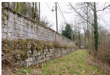
Face interne du rempart est, au niveau du bastion (disparu) des Jésuites. Phot. Jérôme Mongreville IVR43_20233900133NUC4A
