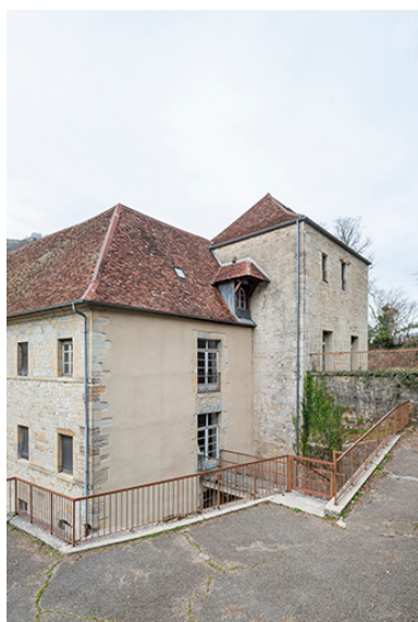
Tour Dorée, accolée au collège. Phot. Jérôme Mongreville IVR43_20233900112NUC4A
