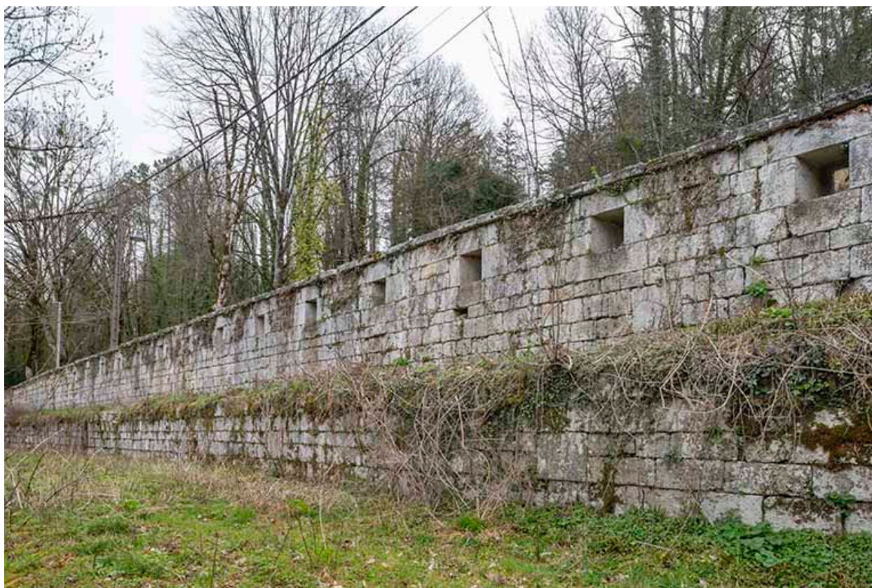
Face interne du rempart est, au niveau du bastion (disparu) des Jésuites.
