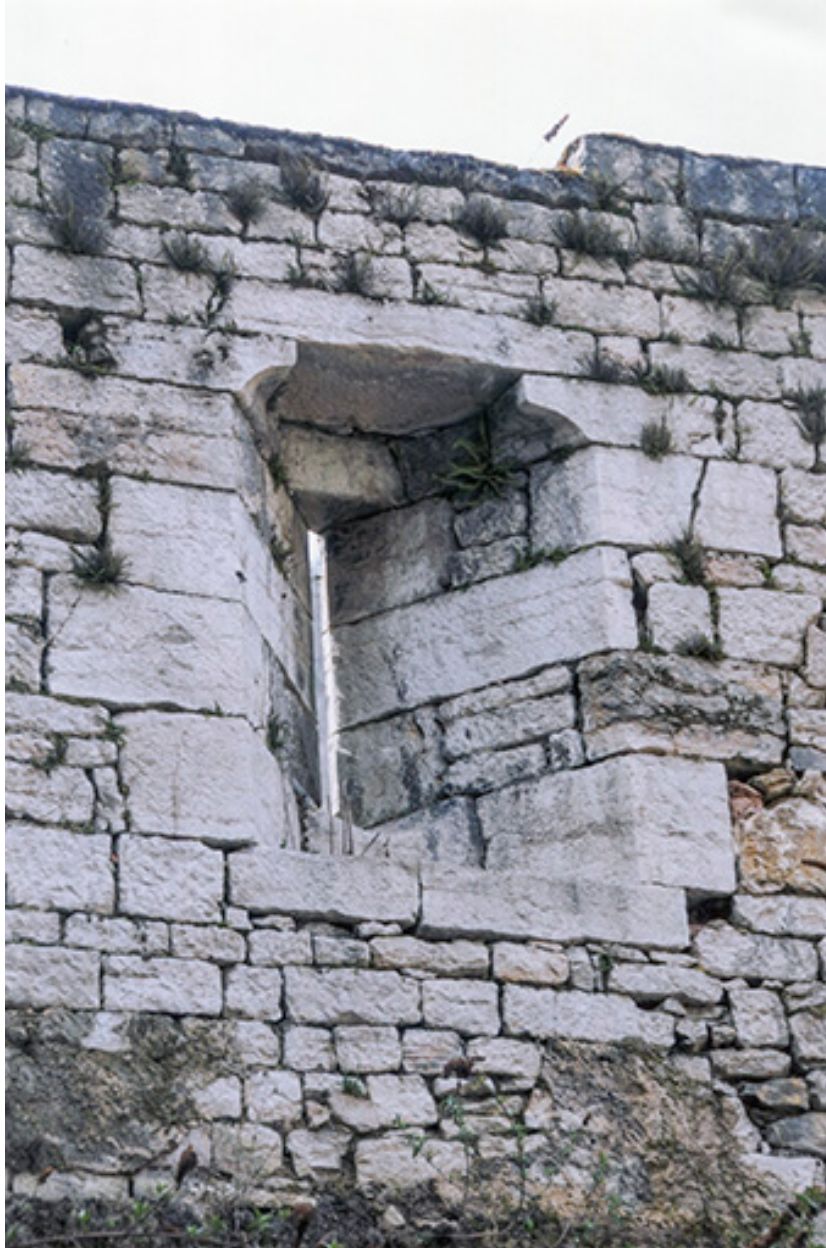
Embrasure de meurtrière dans le rempart conservé au nord du pont Saint-Nicolas, 2011.
