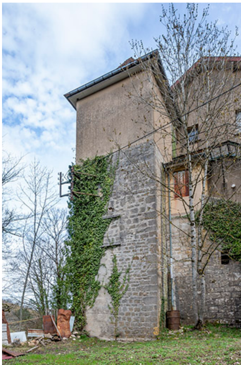
Tour Terrestre, depuis le sud-est.
