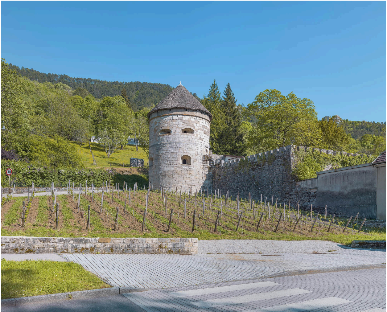
Tour d'Andelot et courtine nord.
