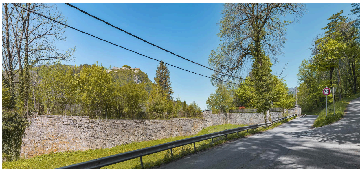
Rempart est, au sud de Châtelguyon.
