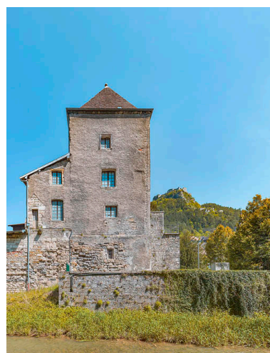
Façade ouest de la tour de Reculot. Phot. Thierry Kuntz IVR43_20223900633NUC4A
