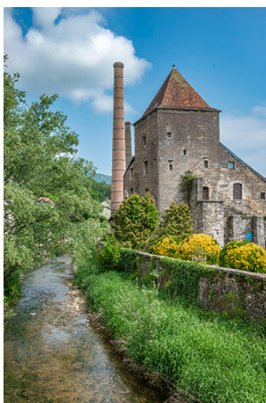
Mur ouest et tour de Reculot. Phot. Jérôme Mongreville IVR43_20233900410NUC4A
