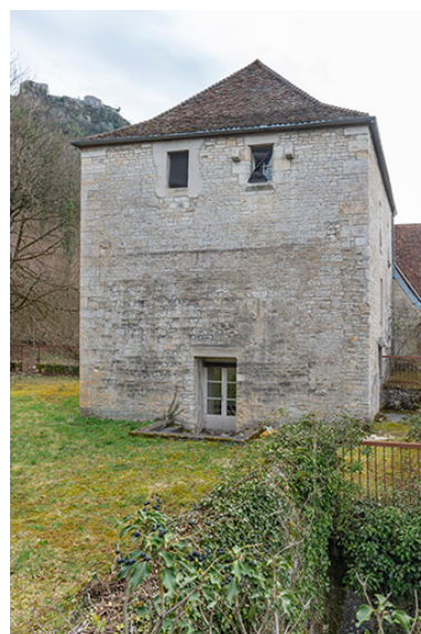
Tour Dorée. Façade nord. Phot. Jérôme Mongreville IVR43_20233900116NUC4A
