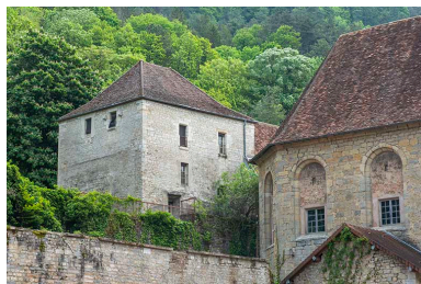
Vue d'ensemble de la tour Dorée. Phot. Jérôme Mongreville IVR43_20233900429NUC4A
