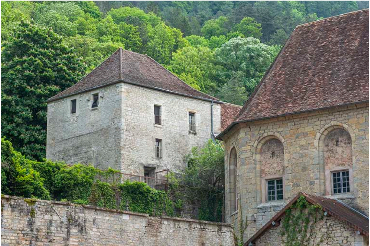
Vue d'ensemble de la tour Dorée.
