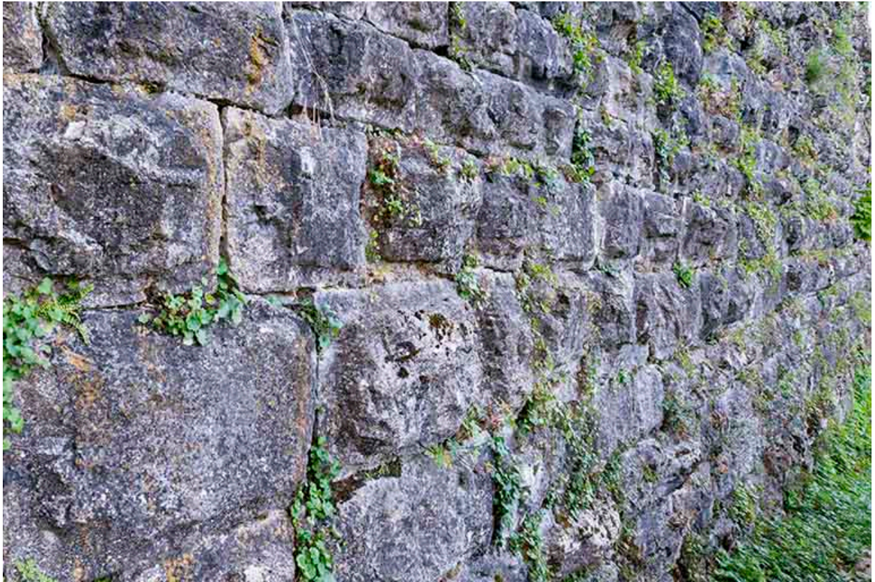
Détail du bossage de la courtine nord, près de la tour d'Andelot.
