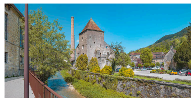
Rempart ouest et tour de Reculot, depuis l'hôpital. Phot. Thierry Kuntz IVR43_20223900632NUC4A
