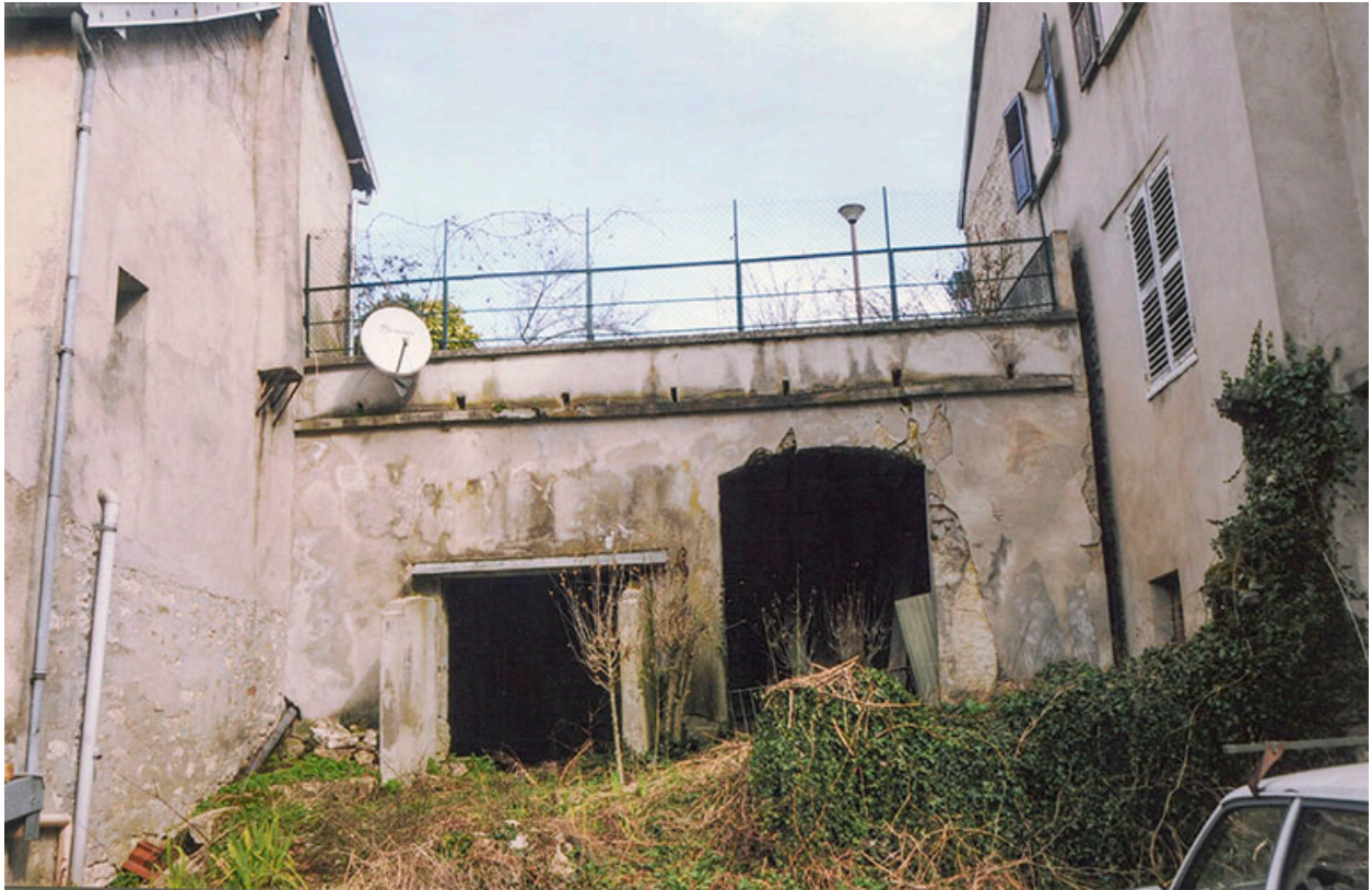
Constructions modernes adossées au mur de courtine nord, rue des Corneux, 2011.
