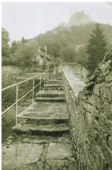
Chemin de ronde arasé longeant la courtine sud, 2011.
