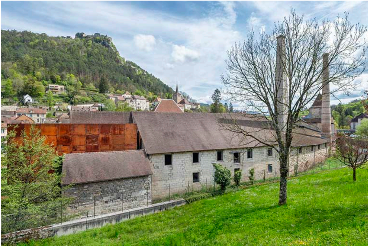
Mur ouest de la saline, longeant la saline.
