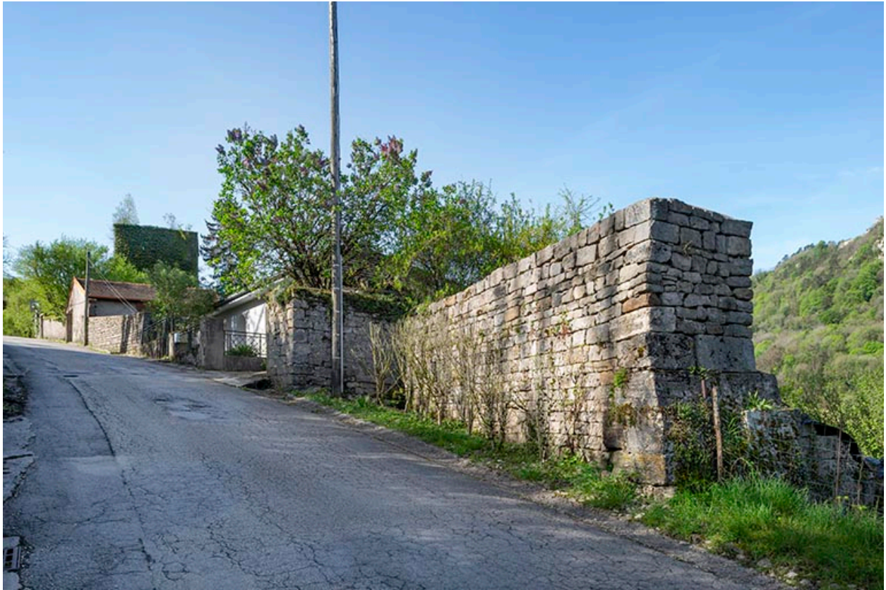
Rempart est dans le haut du chemin de la Tour ronde. Vestiges de la tour d'Aiglepierre.
