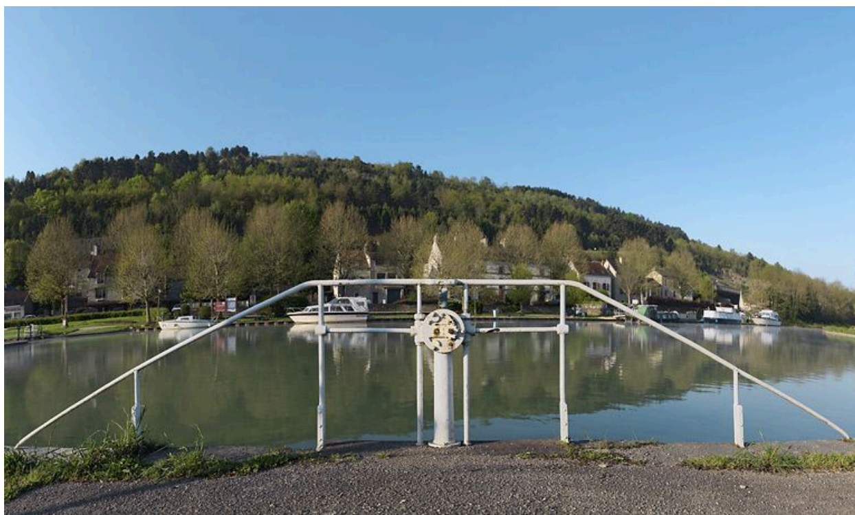
Vanne du déversoir.
