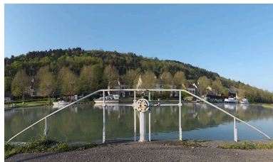
Vanne du déversoir. Phot. Thierry Kuntz IVR26_20112100067NUC4A
