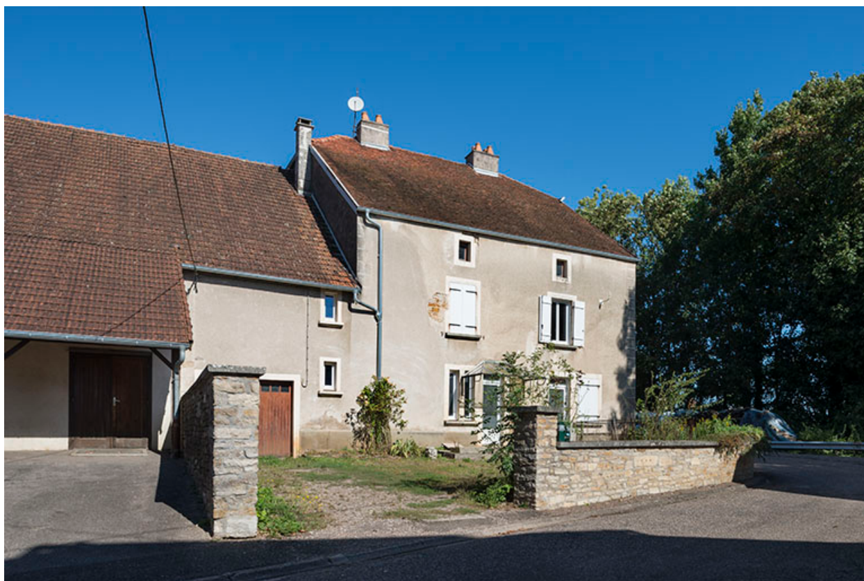
Vue depuis la rue de l'Eglise.
