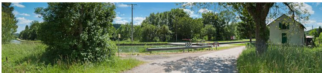
Vue du pignon droit de la maison.
