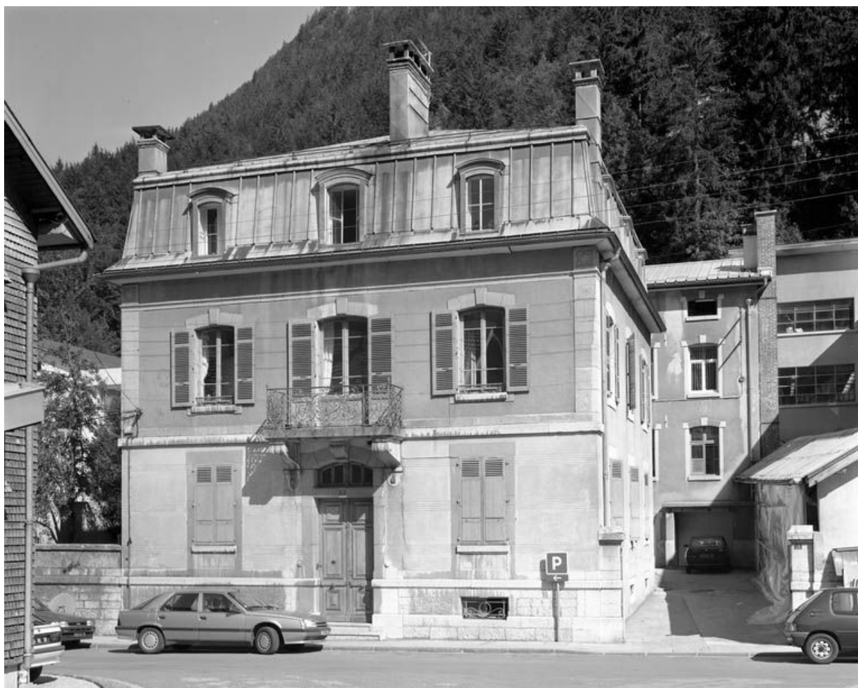
Site ancien : façade antérieure du logement.
