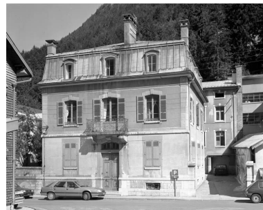
Site ancien : façade antérieure du logement. Phot. Jérôme Mongreville IVR43_19913900857V
