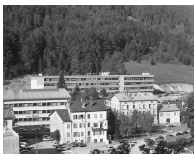
Site récent : bâtiment en retrait de la rue de la République. Phot. Jérôme Mongreville IVR43_19913900940X
