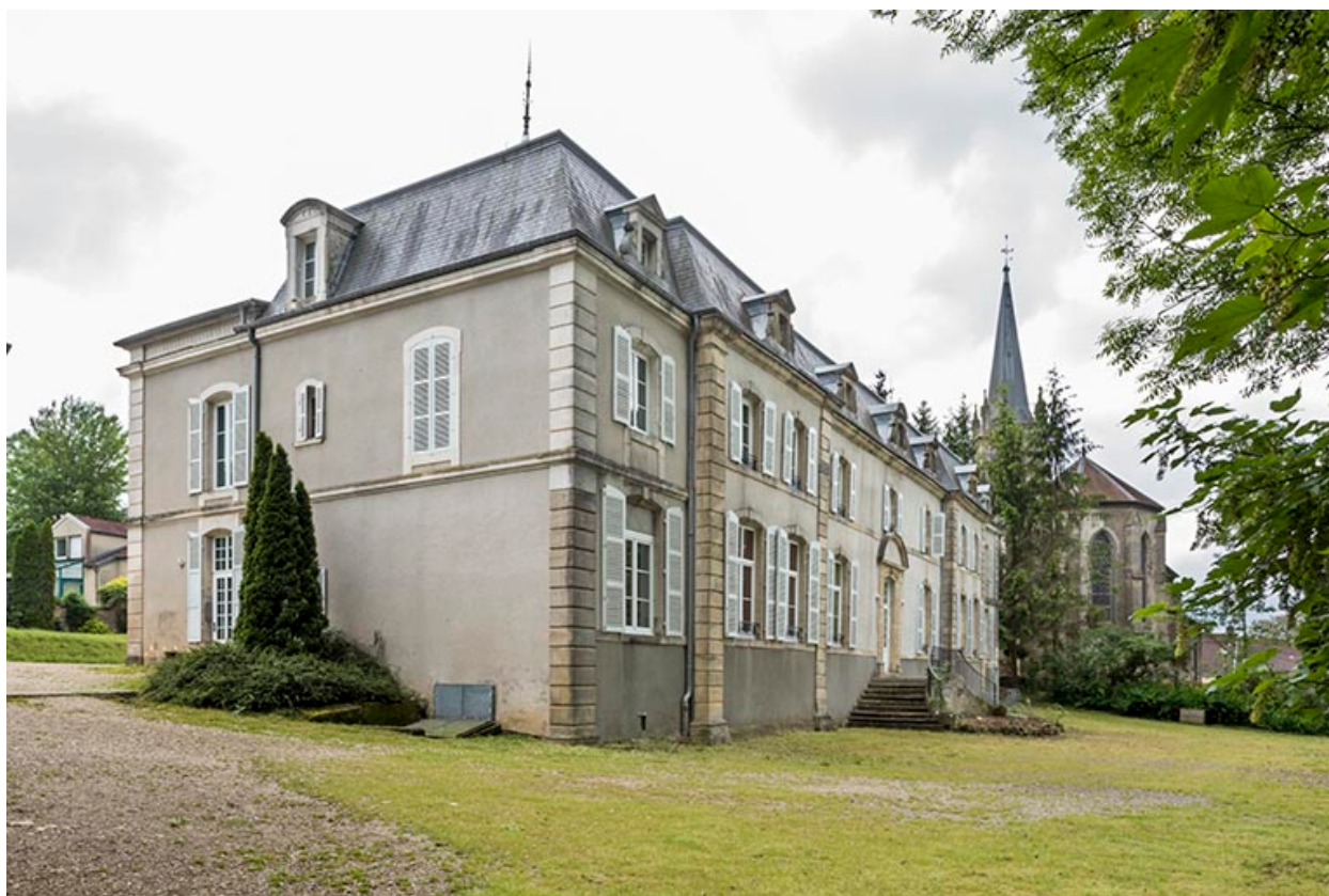
Vue depuis le nord.
