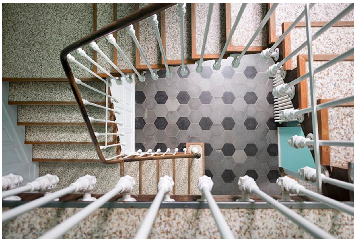
Vue depuis le premier étage.
