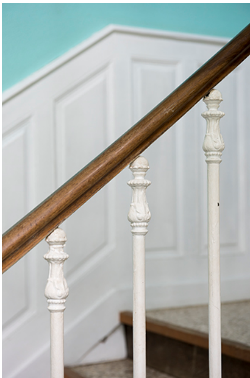
Détail de la rambarde et du garde-corps.
