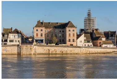
Seurre, rue du Pont : la Cigale. Phot. Pierre-Marie Barbe-Richaud IVR26_20222100070NUC4A
