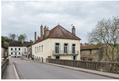
Pontallier-sur-Saône, 62-64 rue du 8 Mai 1945 : le Tivoli. Phot. Pierre-Marie Barbe-Richaud IVR26_20242100189NUC4A
