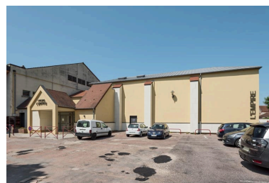
Auxonne, boulevard Pasteur : l'Empire. Phot. Pierre-Marie Barbe-Richaud IVR26_20212100064NUC4A
