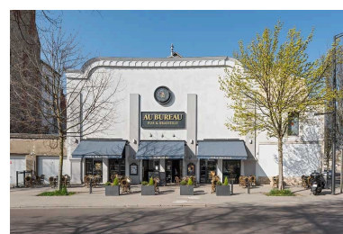
Dijon, 82 rue Devosge et 2 place de la République : l'Alhambra. Phot. Pierre-Marie Barbe-Richaud IVR26_20222100169NUC4A
