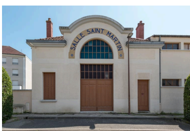
Genlis, 3 rue Aristide Briand : salle paroissiale et cinéma Saint-Martin. Phot. Pierre-Marie Barbe-Richaud IVR26_20212100085NUC4A
