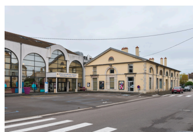
Genlis, 3 rue Jean Jaurès : l'Odéon. Phot. Pierre-Marie Barbe-Richaud IVR26_20242100187NUC4A
