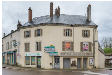
Laignes, 5 Grande Rue de la Maison Dieu : le Vox. Phot. Pierre-Marie Barbe-Richaud IVR26_20242100204NUC4A
