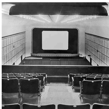
[Dijon] Nouvelle salle de l'Eldorado [vue depuis l'écran et depuis le balcon]. S.d. [3e quart 20e siècle, avant 1971]. Autr. auteur inconnu IVR26_20222100095NUC4
