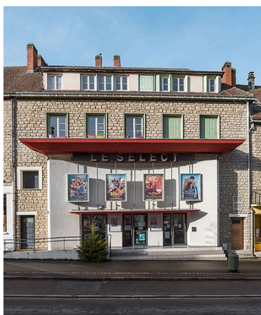
Châtillon-sur-Seine, 46 rue du Maréchal de Lattre : le Select. Phot. Pierre-Marie Barbe-Richaud IVR26_20212100367NUC2A
