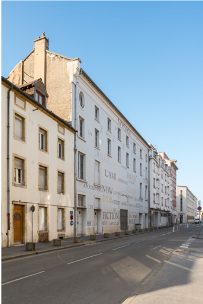
Dijon, 15-19 rue des Perrières : multiplexe Olympia. L'ancien Olympia (puis Gaumont) est au centre ; l'immeuble abritant les salles 9 et 10 le jouxte à droite.
