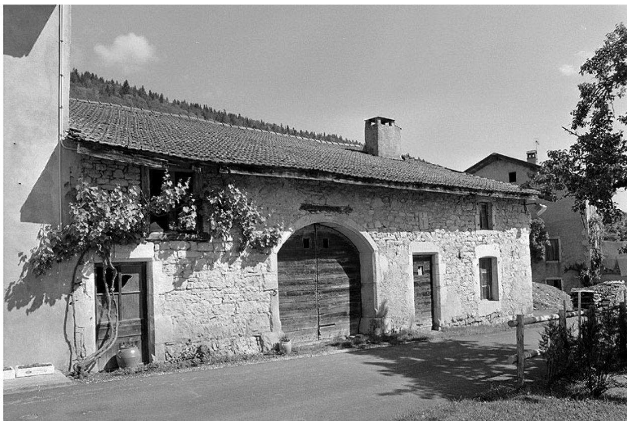
Ferme à trois travées : étable, grange, logis.
